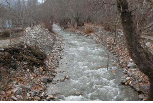
Şekil 3.6. Afşar Ilıcapınar Deresi- Sazak Köprüsü- Dere
