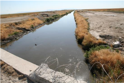
Şekil 3.10. 1 Nolu Pompa Girişi- Apa Tahliye Kanalı- Drenaj Kanalı
