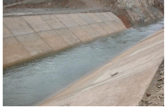
Şekil 3.5. Mamasın Barajı- Baraj çıkışı
