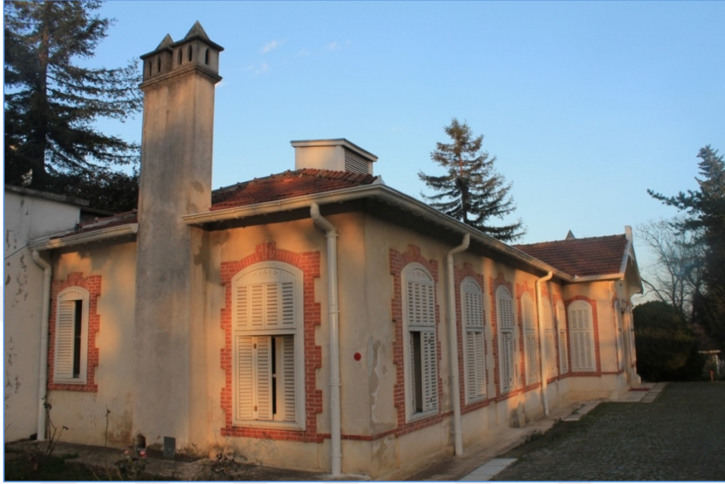
Şekil 5.3-Ağalar Dairesi, güneybatı cephe
