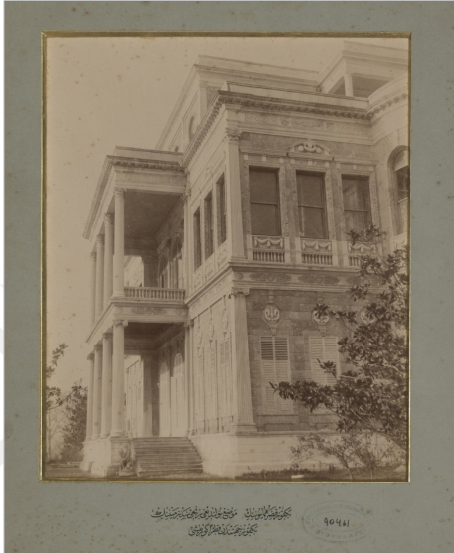
Şekil 1.20- Kuzeybatı cephesi görünümü 173
