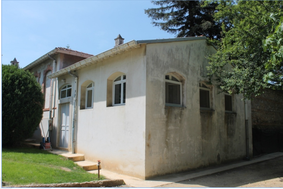
Şekil 5.6 -Hamam, güneydoğu cephe
