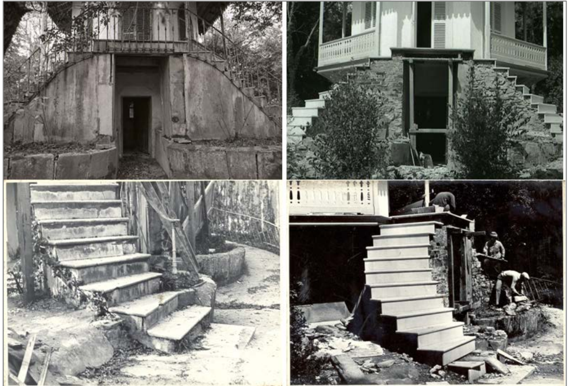
Şekil 6.11- Doğu (giriş) cephesi (1982- 1984 onarımlardan) (TBMM MSFA)
