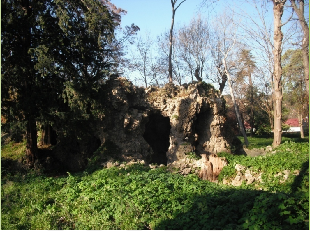
Şekil 1.108- Hava hamamı, dış görünüşü
