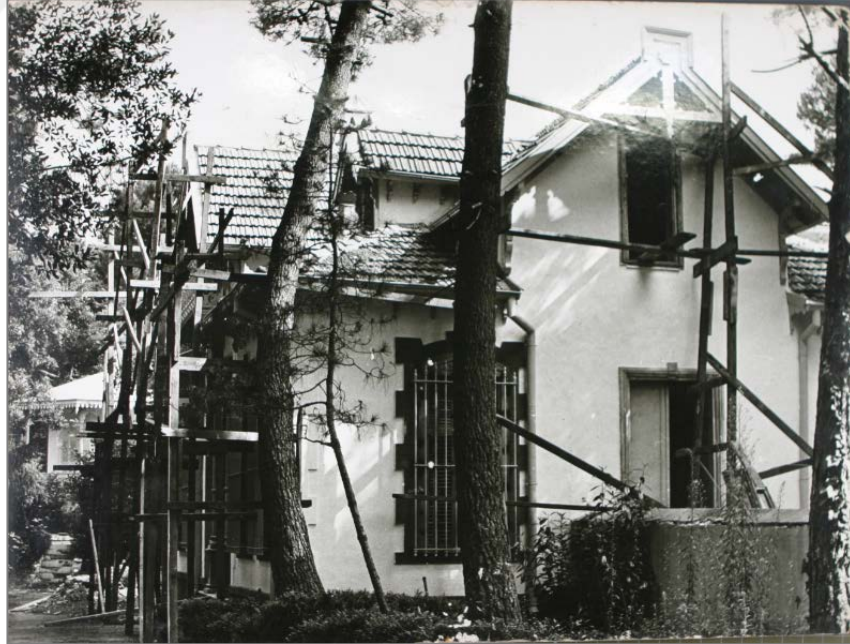
Şekil 4.37- Güney cephe (1981 yılında yapılan onarımlardan)(TBMM MSFA)
