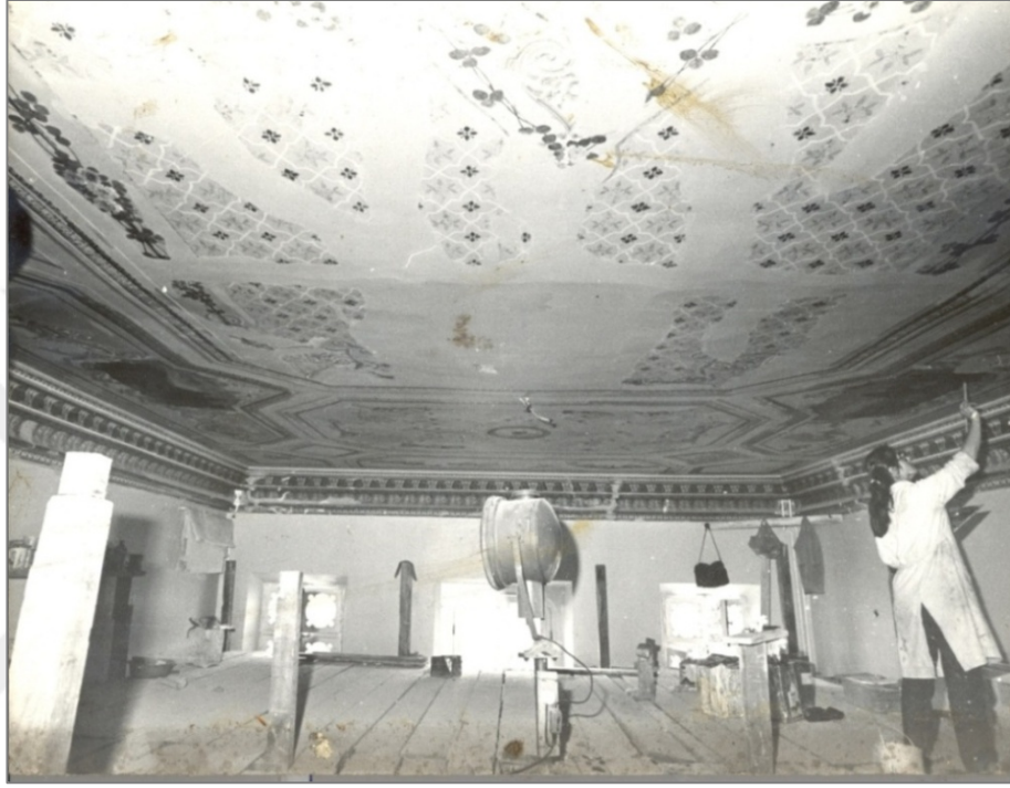
Şekil 3.96- İç mekân onarımları (1981 yılı onarımlardan) (TBMM MSFA)
