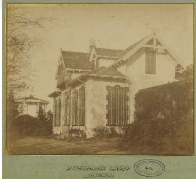
Şekil 4.5- Mabeyn-i Hümayûn güneybatı cephesi 285
