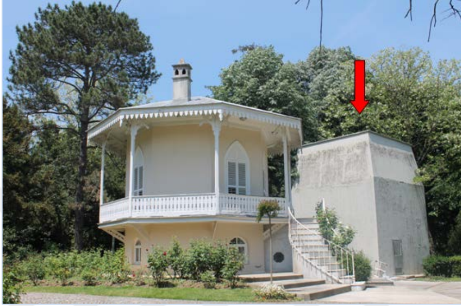
Şekil 7.13- 11 no.lu yapı (Su Deposu)
