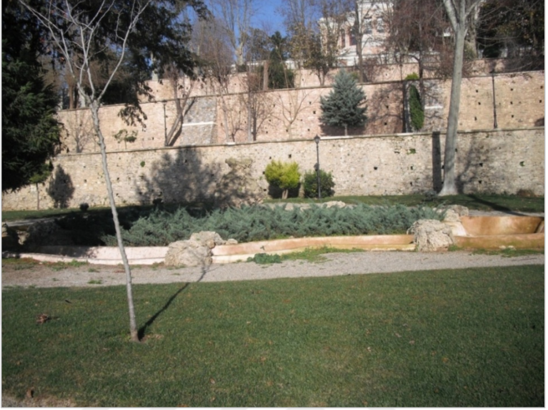
Şekil 1.102- Deniz cephesi istinat duvarları
