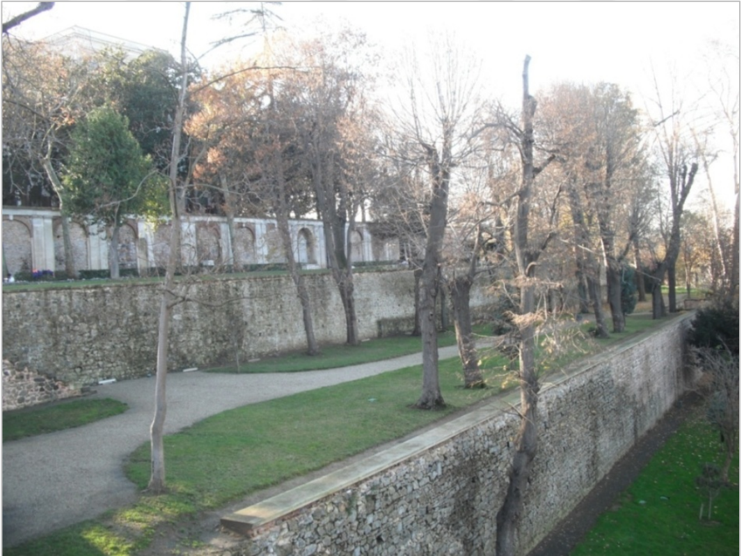
Şekil 1.103- Kara cephesi istinat duvarları
