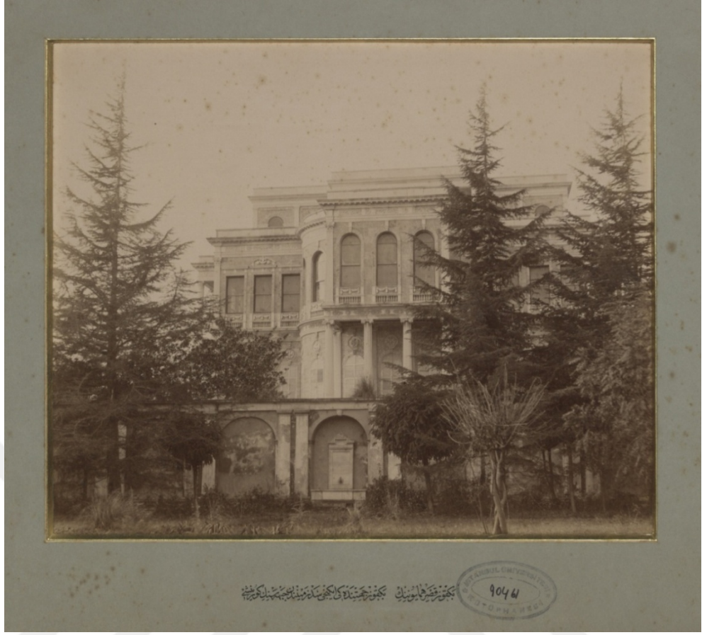
Şekil 1.31- Kuzeydoğu cephe görünümü 176
