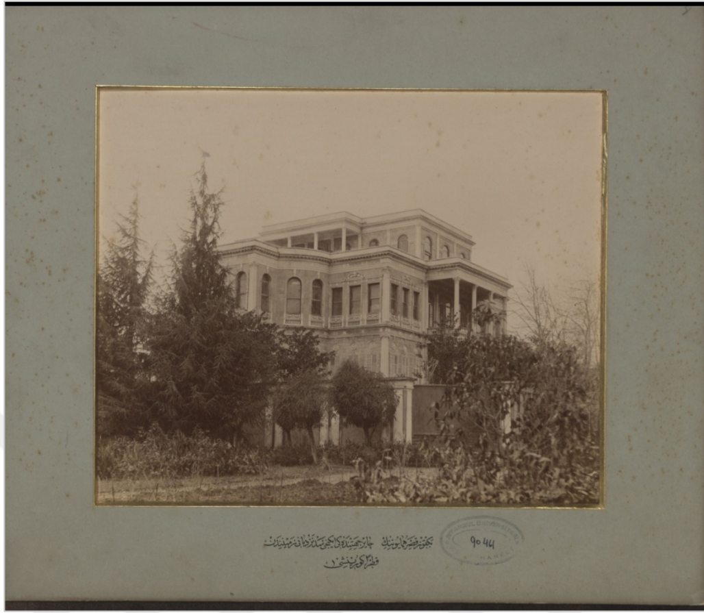
Şekil 1.27- Güneydoğu cephe görünümü 175
