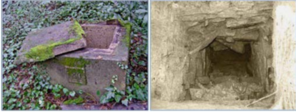
Şekil 2.1- Maslaklara su taşıyan kanalın (solda) 181 no.lu bacası, (sağda) iç görünümü 209
