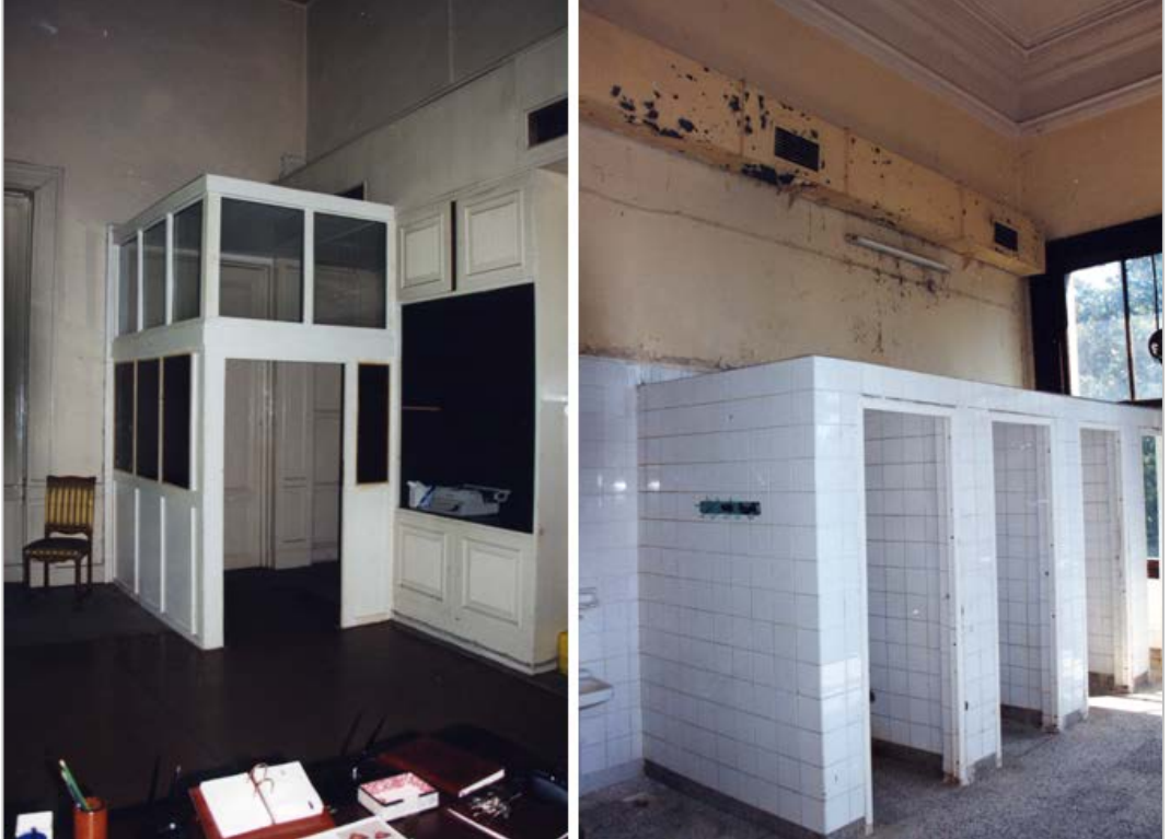
Şekil 1.91- Onarım öncesi iç görünüm (1999-2005) (TBMM MSFA)
