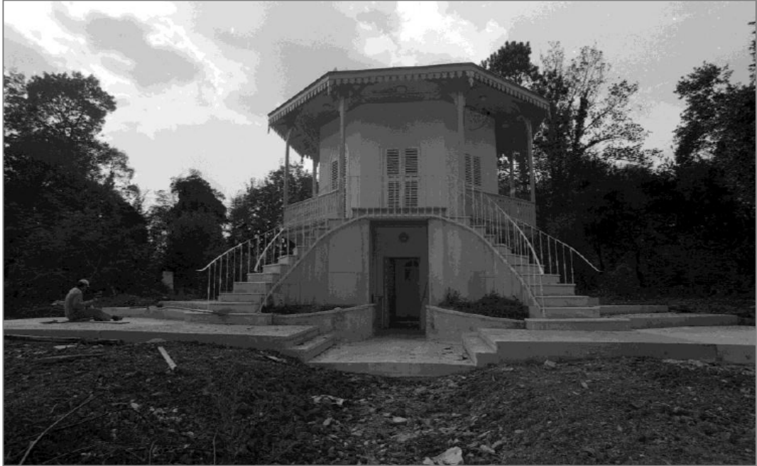
Şekil 6.14- Doğu cephesi (onarımlardan) (TBMM MSFA)
