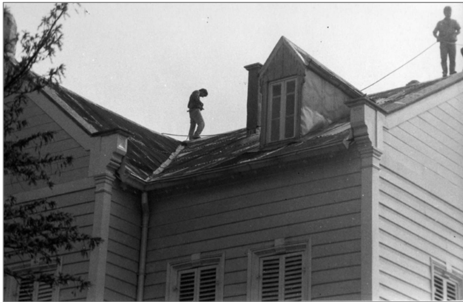
Şekil 3.95- Çatı onarımı (1981 yılında yapılan onarımlardan)(TBMM MSFA)
