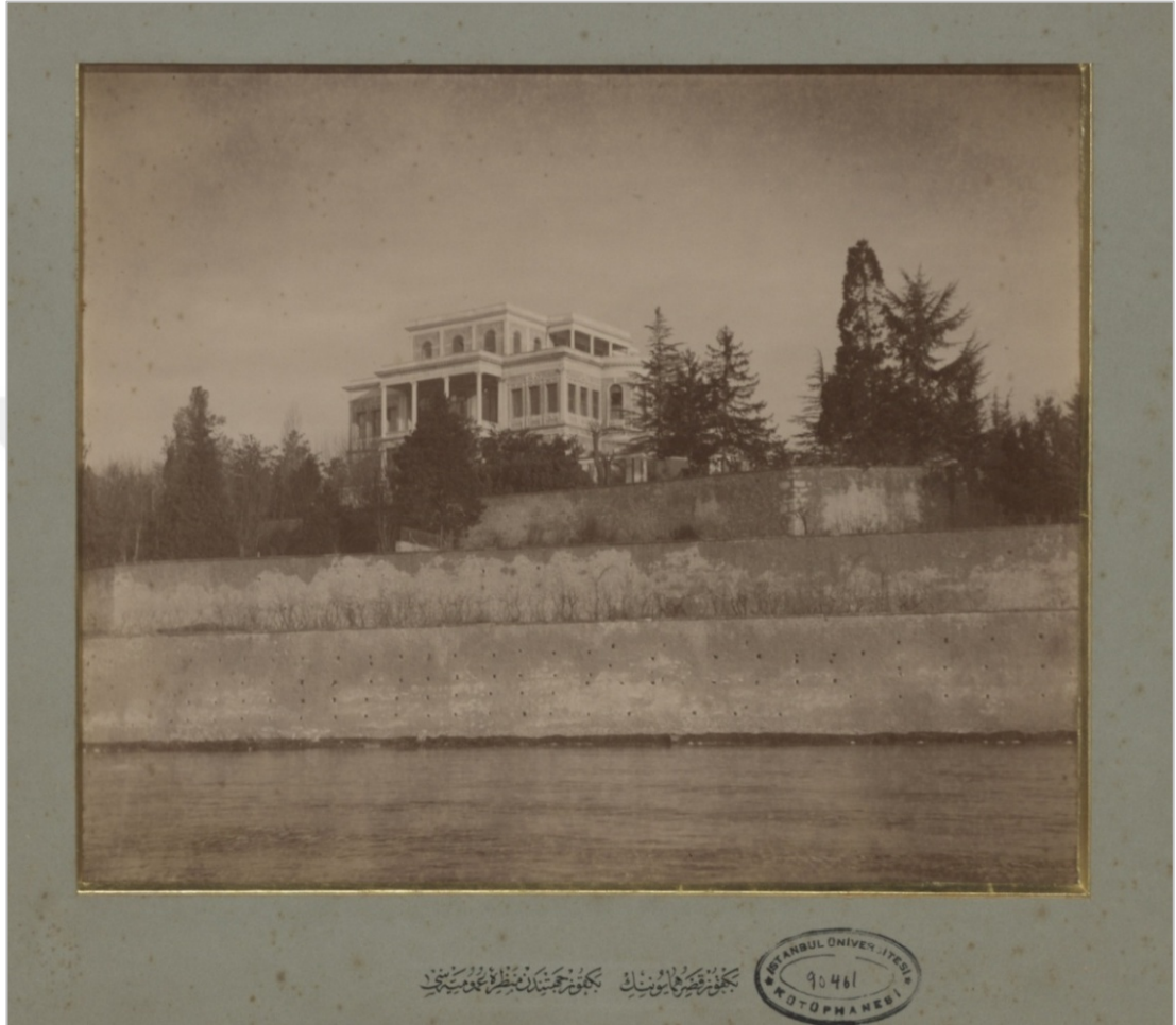
Şekil 1.101- Deniz cephesi istinat duvarları 199
