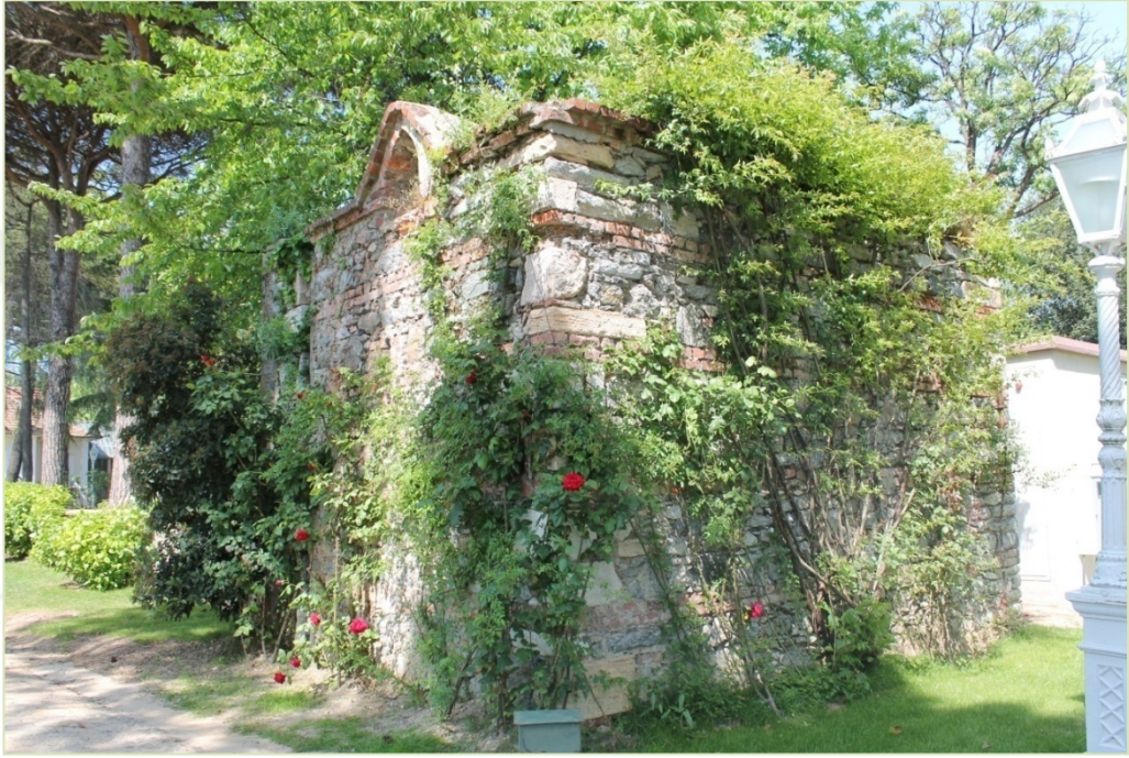
Şekil 7.4- 2 no.lu yapı (Su Deposu)
