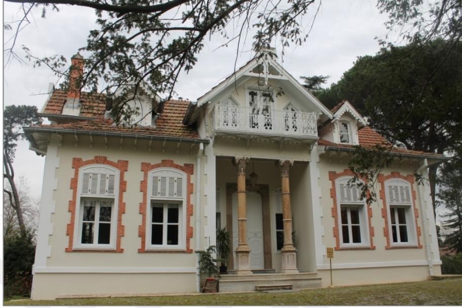
Şekil 4.4- Mabeyn-i Hümayûn, batı cephesi
