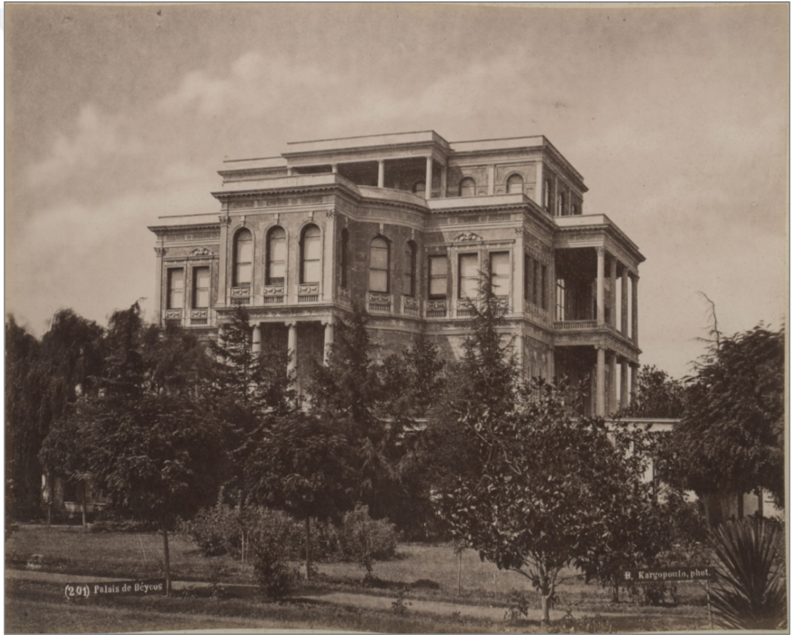
Şekil 1.18- Güneydoğu cephe görünümü 172
