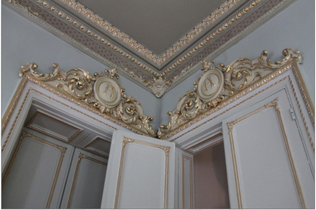
Şekil 4.31- 2 no.lu oda, tavan eteği ve kapı tepeliği süslemeleri
