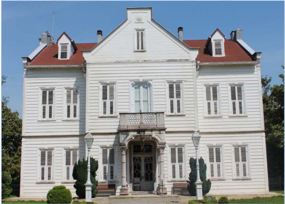
Şekil 3.10- Kasr-ı Hümâyûn ön cephesi
