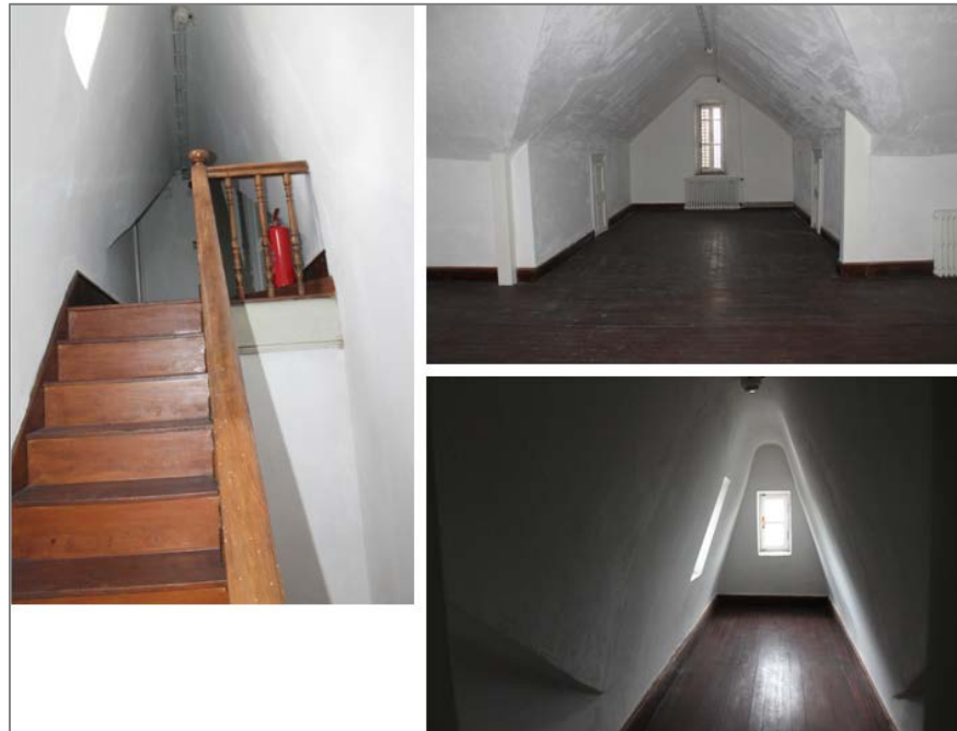
Şekil 3.28- Çatı katına çıkan merdiven ve çatı katı odaları
