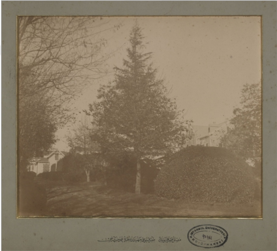
Şekil 2.17- Dış bahçe güney tarafı 350
