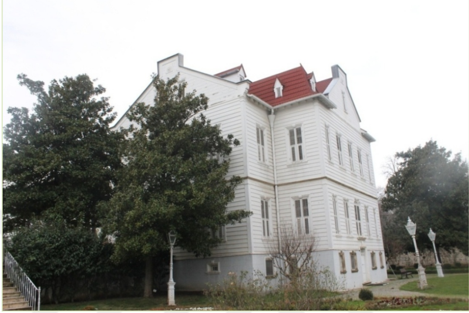
Şekil 3.12- Kasr-ı Hümayûn güneydođu cephe
