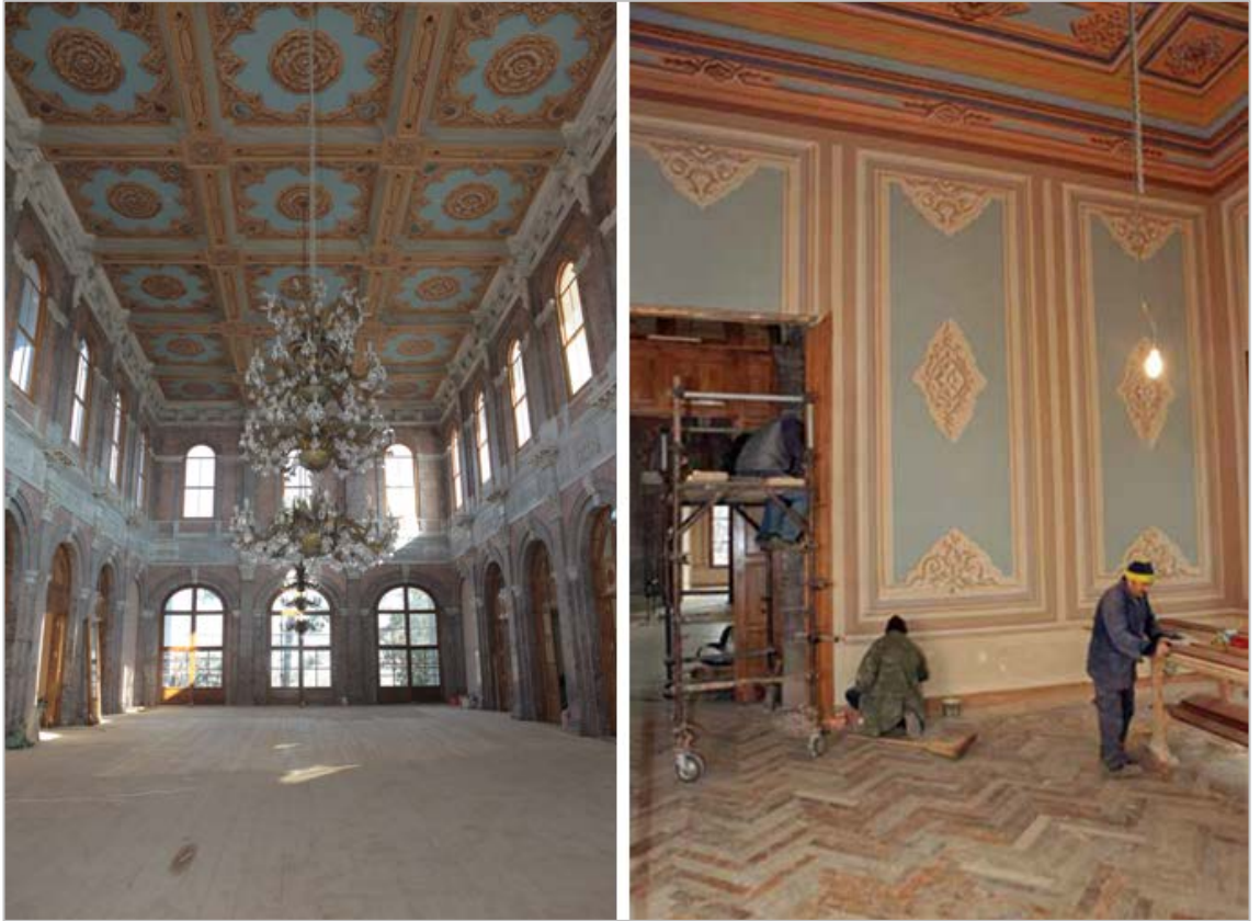
Şekil 1.94- Kasrın restorasyon çalışmaları (TBMM MSFA)
