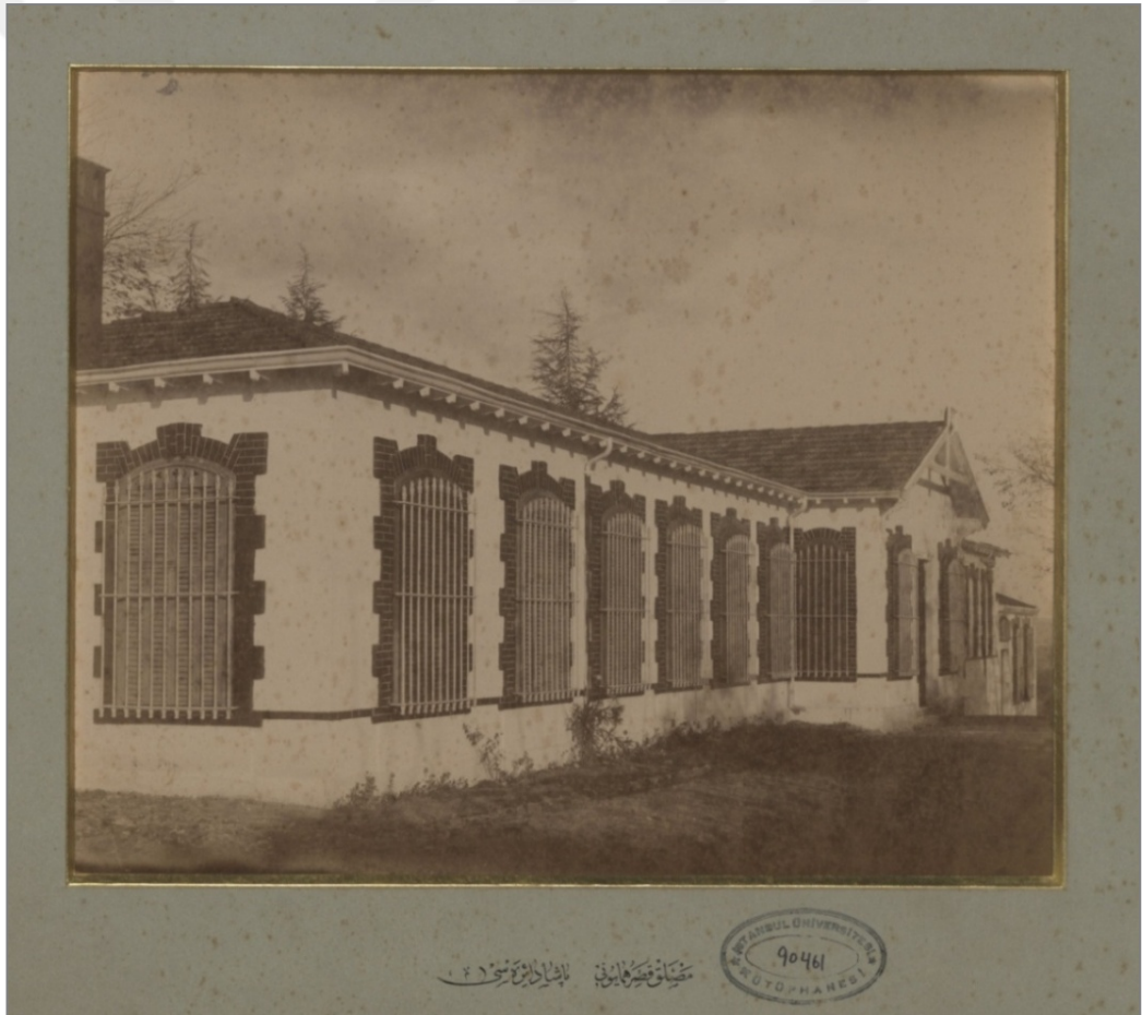
Şekil 5.2-Ağalar Dairesi, güneybatı cephe 306
