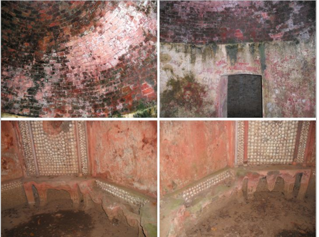
Şekil 1.109- Hava hamamı, iç görünümü
