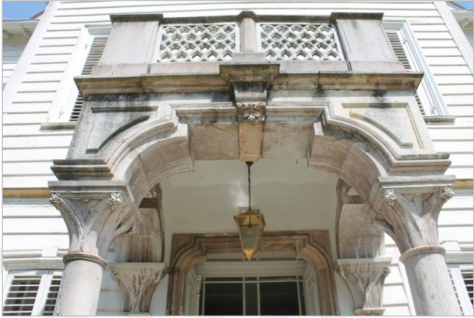
Şekil 3.7- Kasr-ı Hümayûn ön cephe sundurma ve balkon
