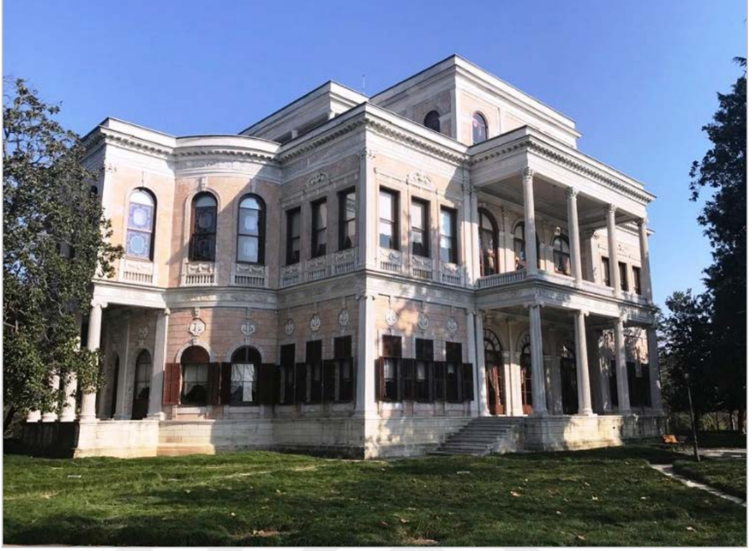
Şekil 1.22- Kuzeydoğu cephe görünümü
