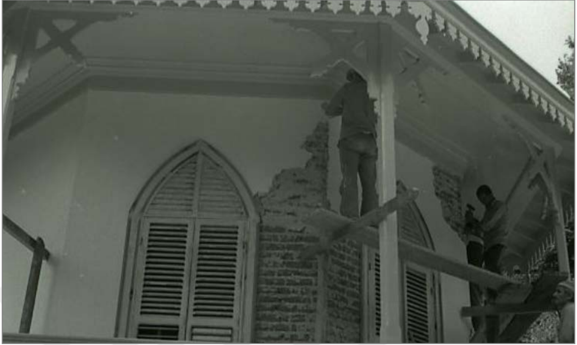
Şekil 6.12- Kuzey cephe( onarımlardan ) (TBMM MSFA)
