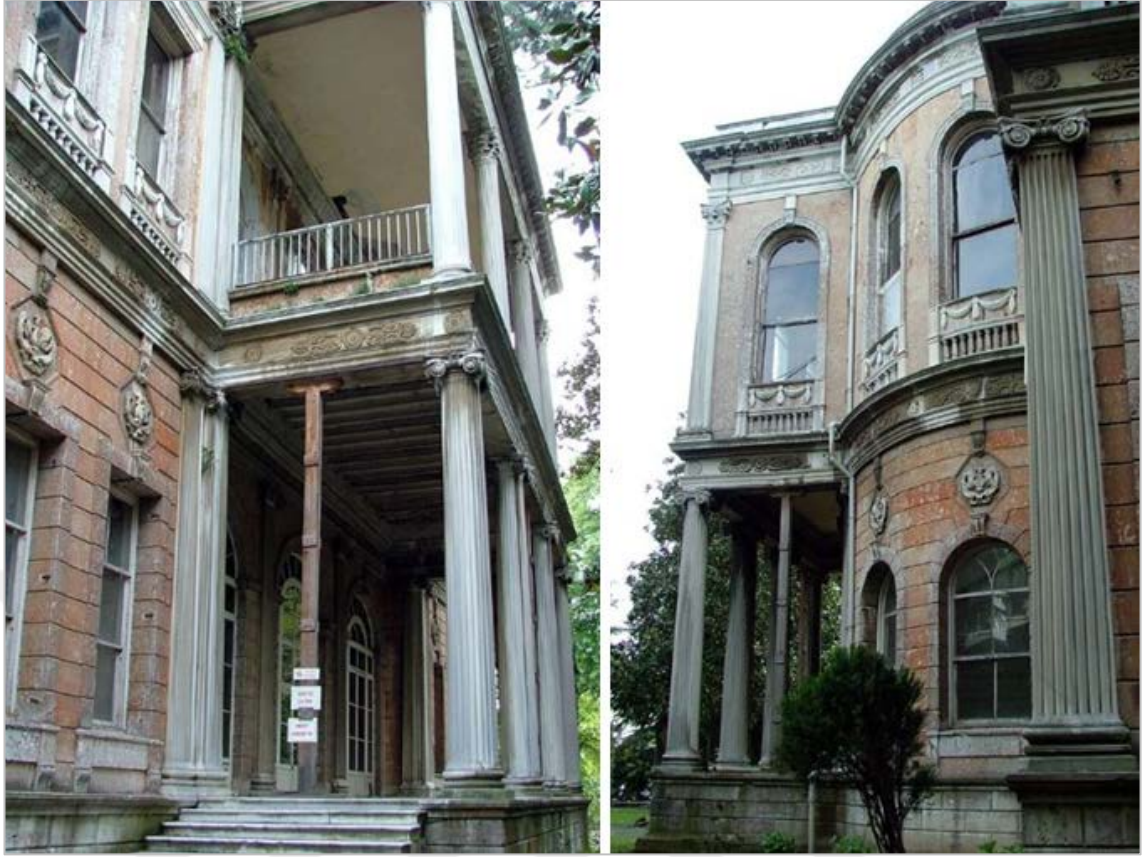
Şekil 1.92- Onarım öncesi cephelerden görünüşler (TBMM MSFA)
