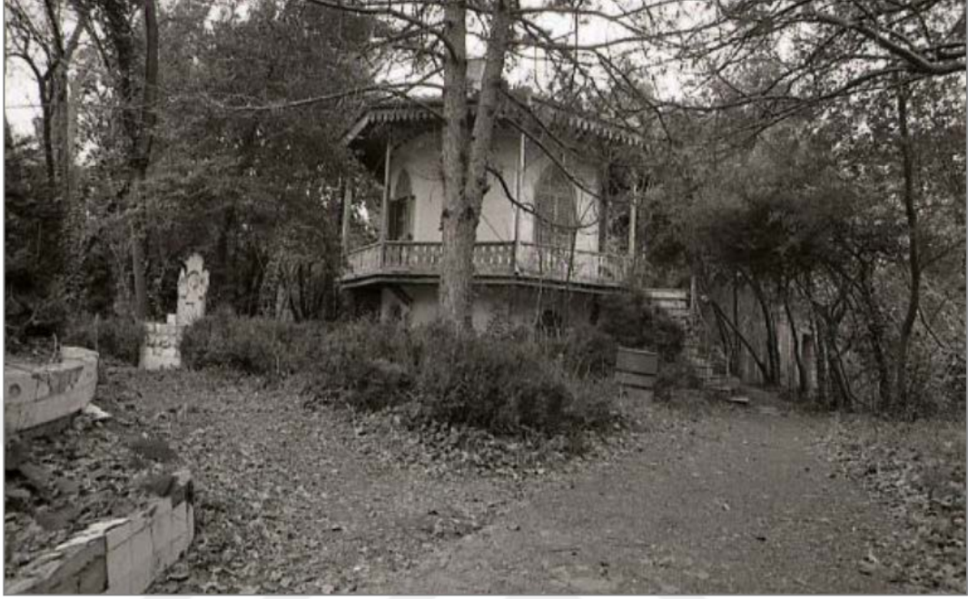
Şekil 6.13- Onarım öncesi güney cephesi (TBMM MSFA)
