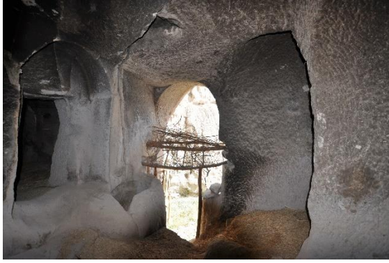
Resim 13. Kilise 1, giriş mekanı, kapıya bakış
