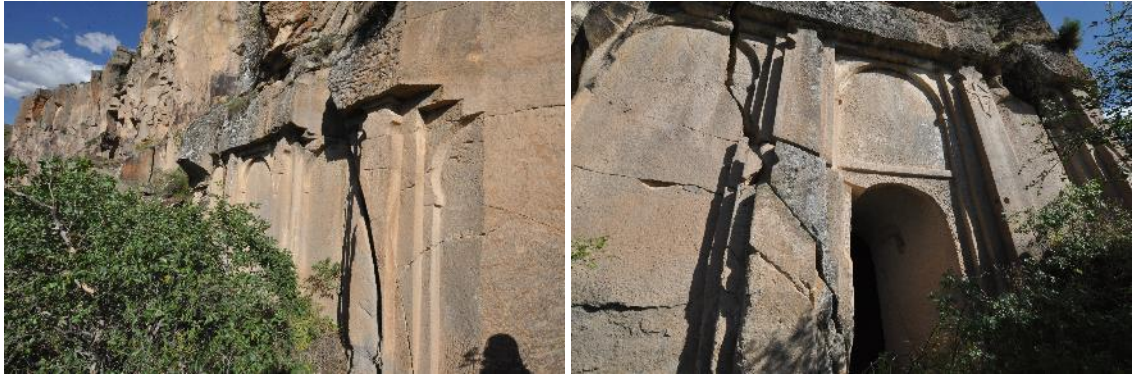
Resim 560. KOM 5, cephe düzenlemesi
