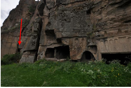
Resim 205. Kuzey Ambar Kilisesi, konum, güneydoğuya bakış
