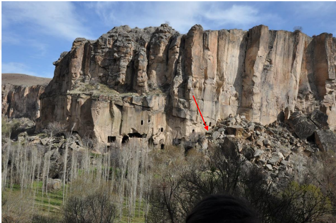
Resim 176. Kilise 11 konum, güneydoğuya bakış
