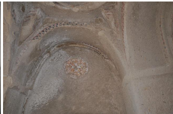
Resim 392. Kilise 4, kubbe geçişleri ve tonoz aynalığı
