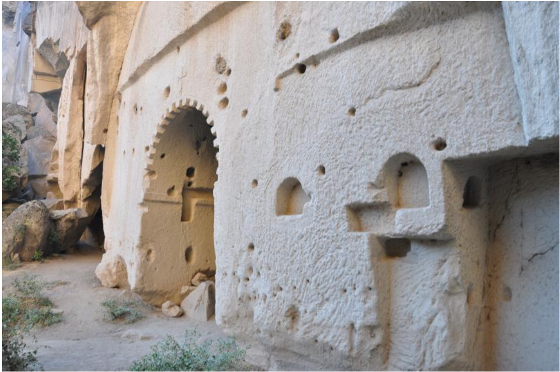
Resim 468. Karanlık Kale yapı topluluğu, güney cepheye bakış
