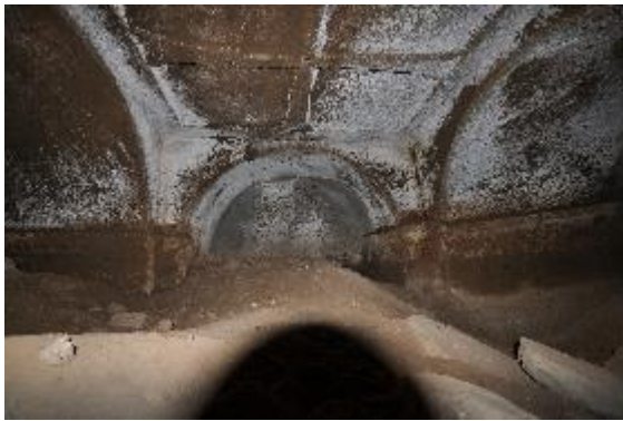
Resim 503. Kilise 17, Mekan 2, girişten güneye bakış
