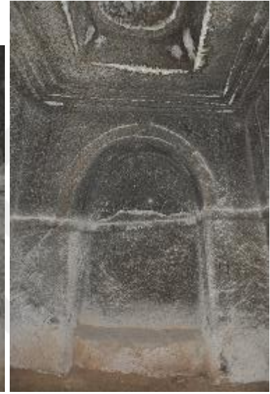
Resim 489. Mekan 3, kuzeye bakış
