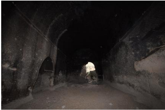
Resim 546. KOM 1, Mekan 1, güneye bakış
