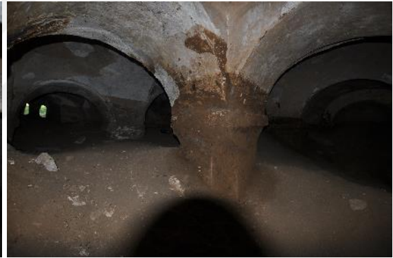
Resim 500. Kilise 17, naos, kuzeydoğuya bakış
