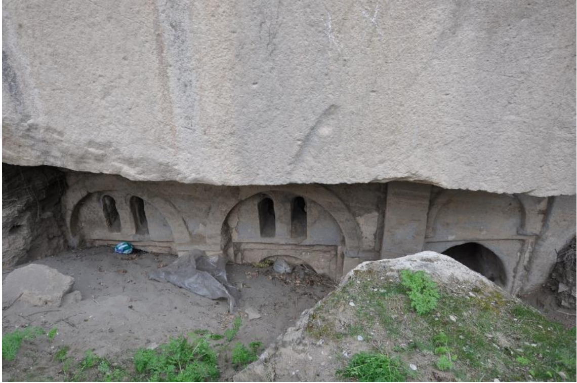
Resim 496. Kilise 17, kuzey cephe
