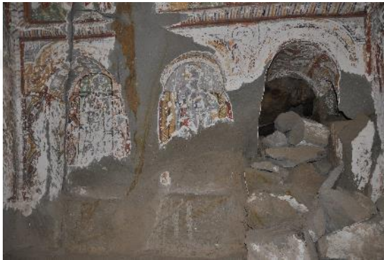
Resim 331. Pürenli Seki Klisesi, kuzey nef, kuzey duvar
