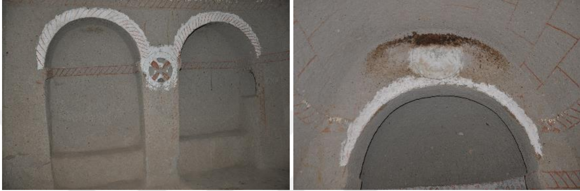
Resim 138. Kilise 10, naos, kuzey duvarındaki nişler Resim 139. Kilise 10, apsis zafer kemeri
