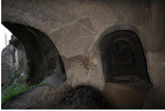
Resim 351. Eski Baca Kilisesi, Mekan 1'den güney nefeye bakış
