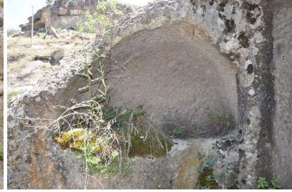
Resim 371. Kilise 18, giriş mekanı güney duvar
