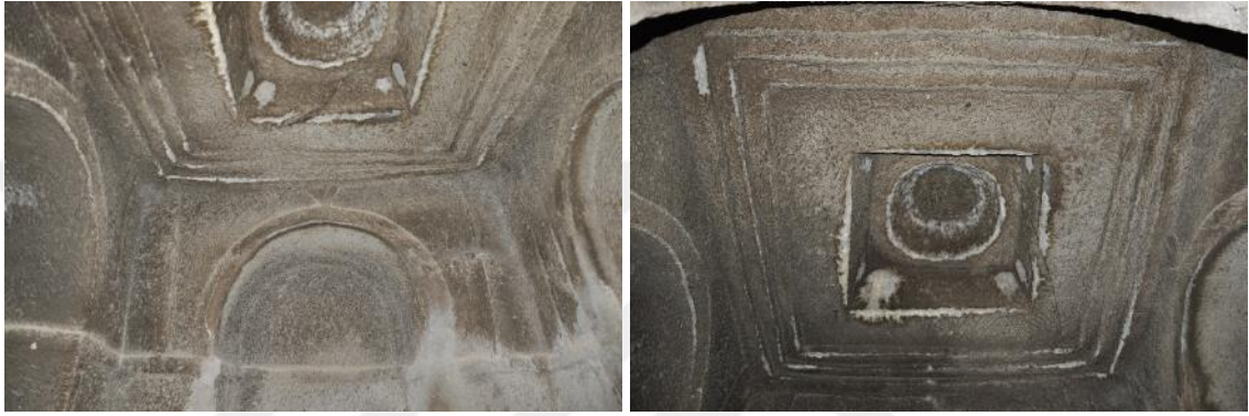
Resim 479. Karanlık Kale, Mekan 3, doğuya bakış Resim 480. Karanlık Kale, Mekan 3, örtü
