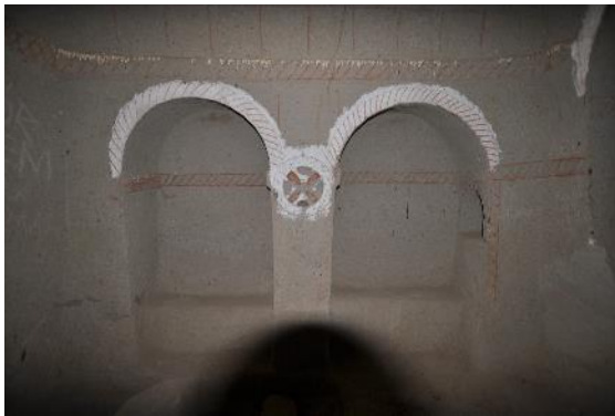
Resim 134. Kilise 10, naos, kuzey duvar
