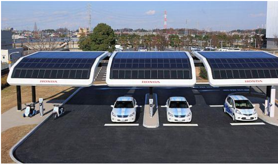
Şekil 1.3. Taşıtların park alanlarına yerleştirilen PV modülleri ve şarj istasyonları (Anonymous 2013a-f)
