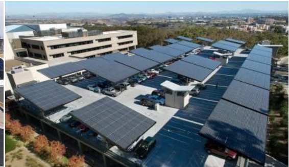
Şekil 1.3. Taşıtların park alanlarına yerleştirilen PV modülleri ve şarj istasyonları (Anonymous 2013a-f)
