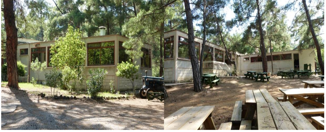
Şekil 3.2 Müze Binası (Müge Altınalan Arşivi 2012)
