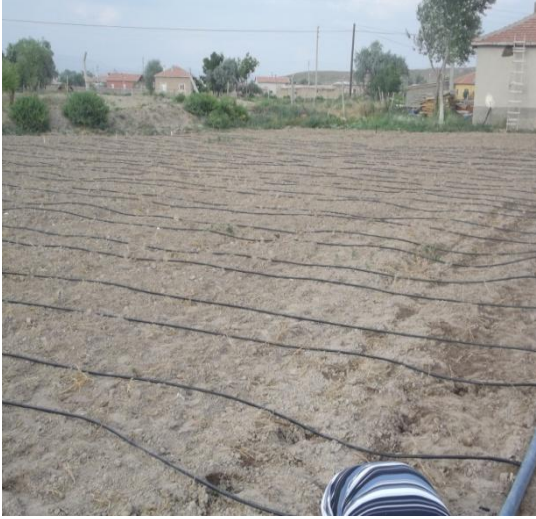
Şekil 3.4. Damla sulama sisteminin kurulması
