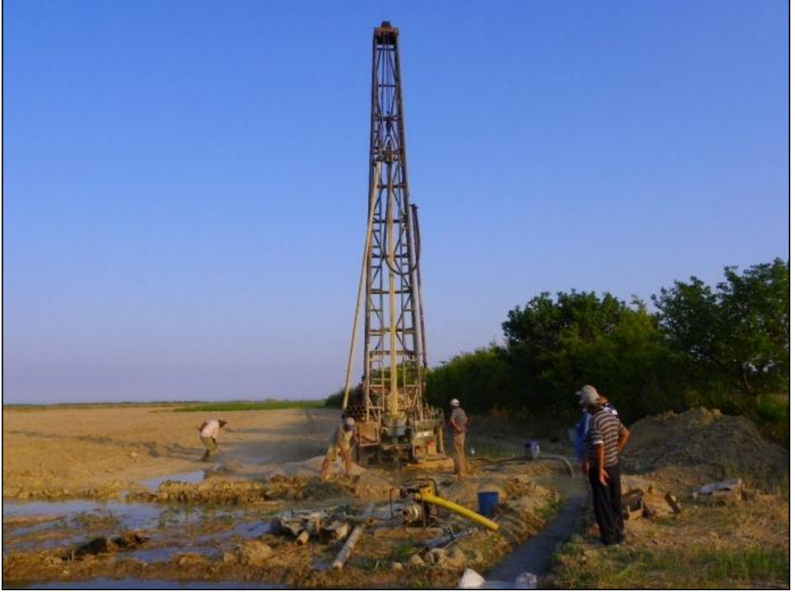
Şekil 7.3 Tez çalışması kapsamında gerçekleştirilen sondaj çalışması (Akgöl kuzeyi-AK-1 nolu sondaj)
