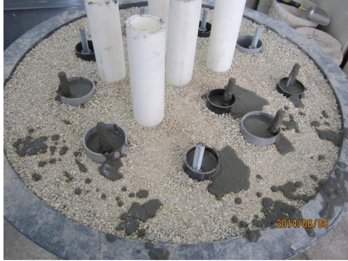
Şekil 4.5. Muhafaza borularının içerisine beton dökülmesi
