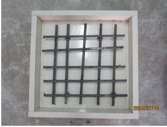
a) Kalıbın yağlanması ve alt sıra donatılarının yerleştirilmesi
