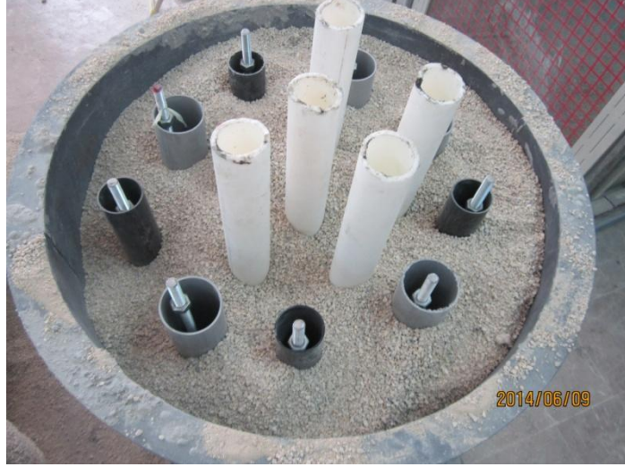
Şekil 4.4. Muhafaza borularının yerleştirilmesi ve etrafının zeminle doldurulması
