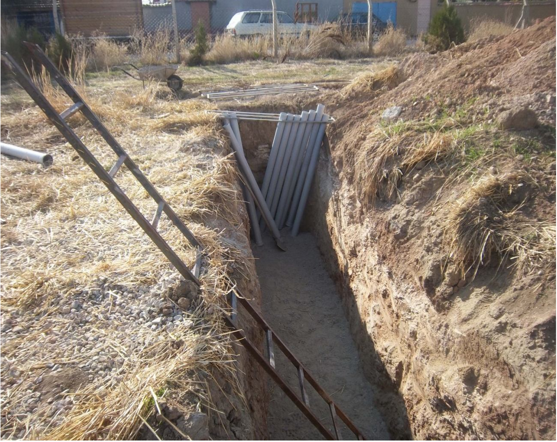
Ek-5 Arazi şartlarında tüplerin iş makinesi tarafından açılmış çukurlara yerleştirilmesi
