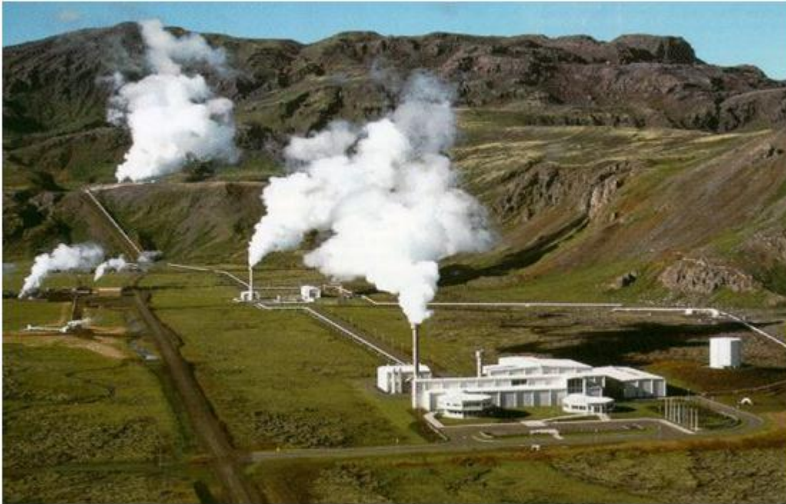
Şekil 2.6. Jeotermal enerji kaynaklı elektrik üretim santrali (Anonim 2015-1)
