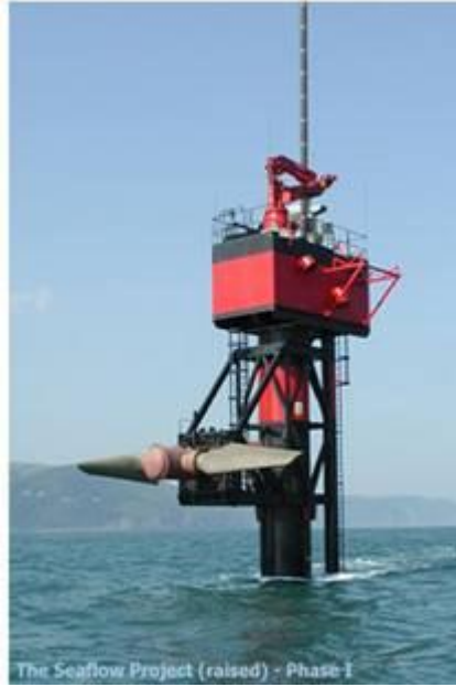
Şekil 2.8. Deniz akıntı jeneratörü (Utandır Ö. 2015)
