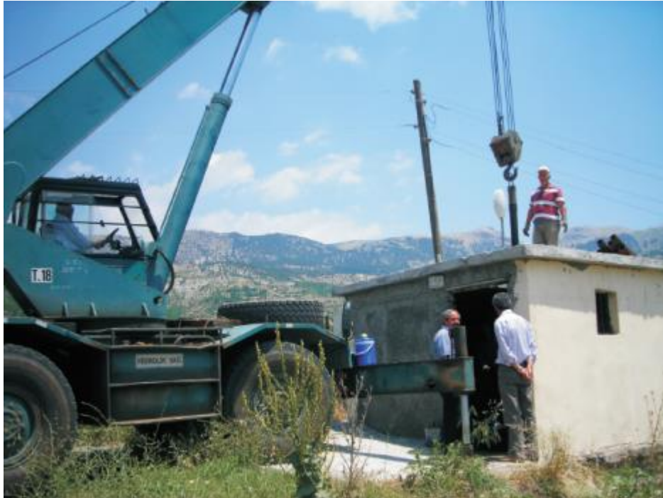
Şekil 3.17. S-2 (TK-5) nolu sıcak su sondajının görünümü (2012)
