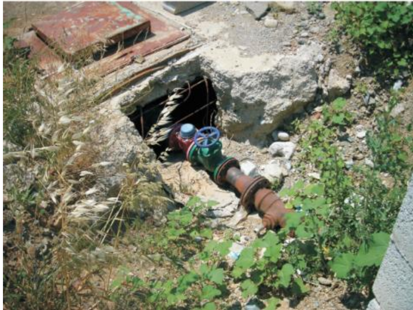
Şekil 3.12. KI-5 (TK-2) nolu sıcak su sondajının görünümü (2012)
