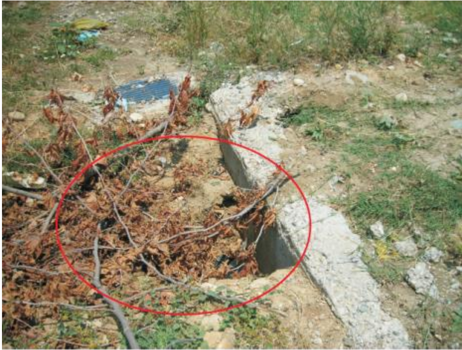
Şekil 3.16. Kapatılan TK-4 nolu sondaj kuyusunun yeri (2012)
