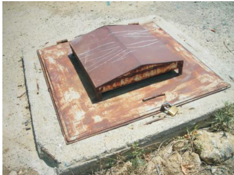
Şekil 3.14. KI-4 (TK-3) nolu sıcak su sondajının görünümü (2012)
