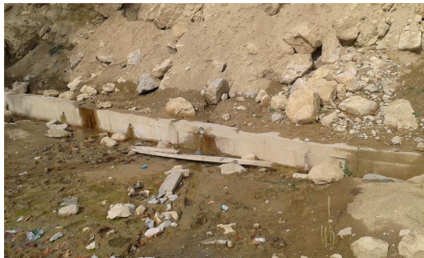
Şekil 3.7. Tekke Kaynağı'nın görünümü
