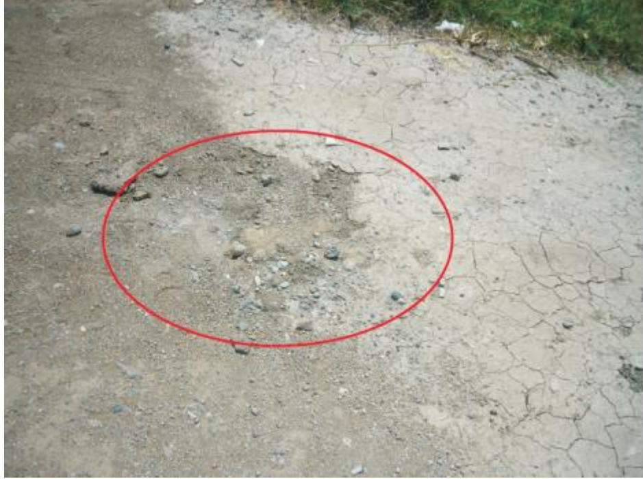
Şekil 3.19. Kapatılan TK-6 nolu sondaj kuyusunun yeri (2012)
