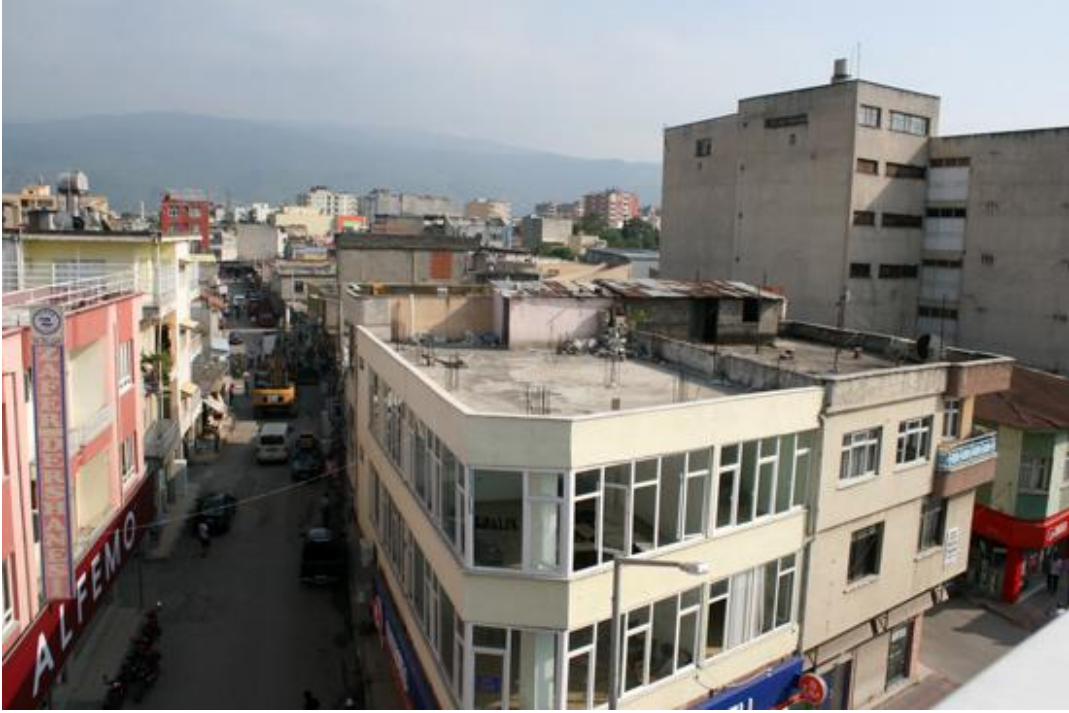
Şekil 6.20. Alanda gözlenen trafik durumu (Belediye arşivi, 2008)
