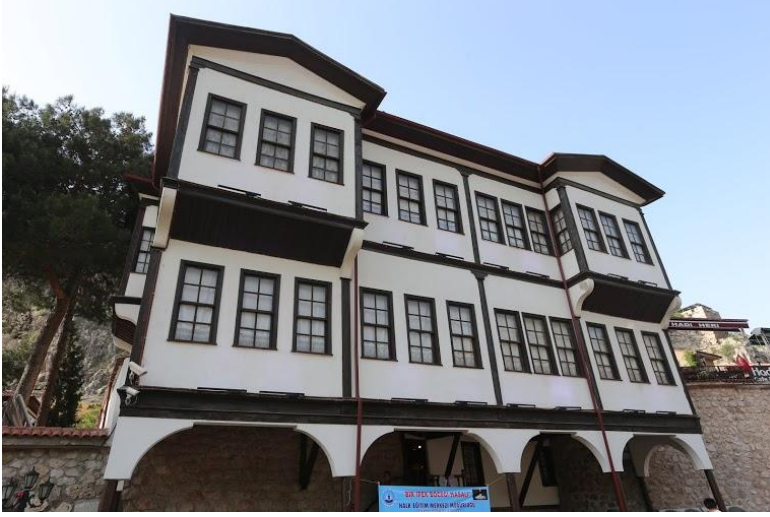
Şekil 4.20. Amasya Hazeranlar Konağı
