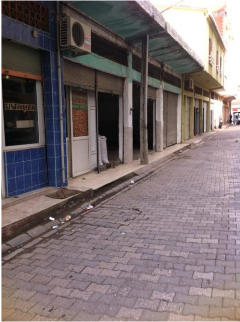
Şekil 6.15. Sağlıklaştırma çalışmasından önce alanda gözlenen sokak dokusu (Belediye arşivi, 2008)
