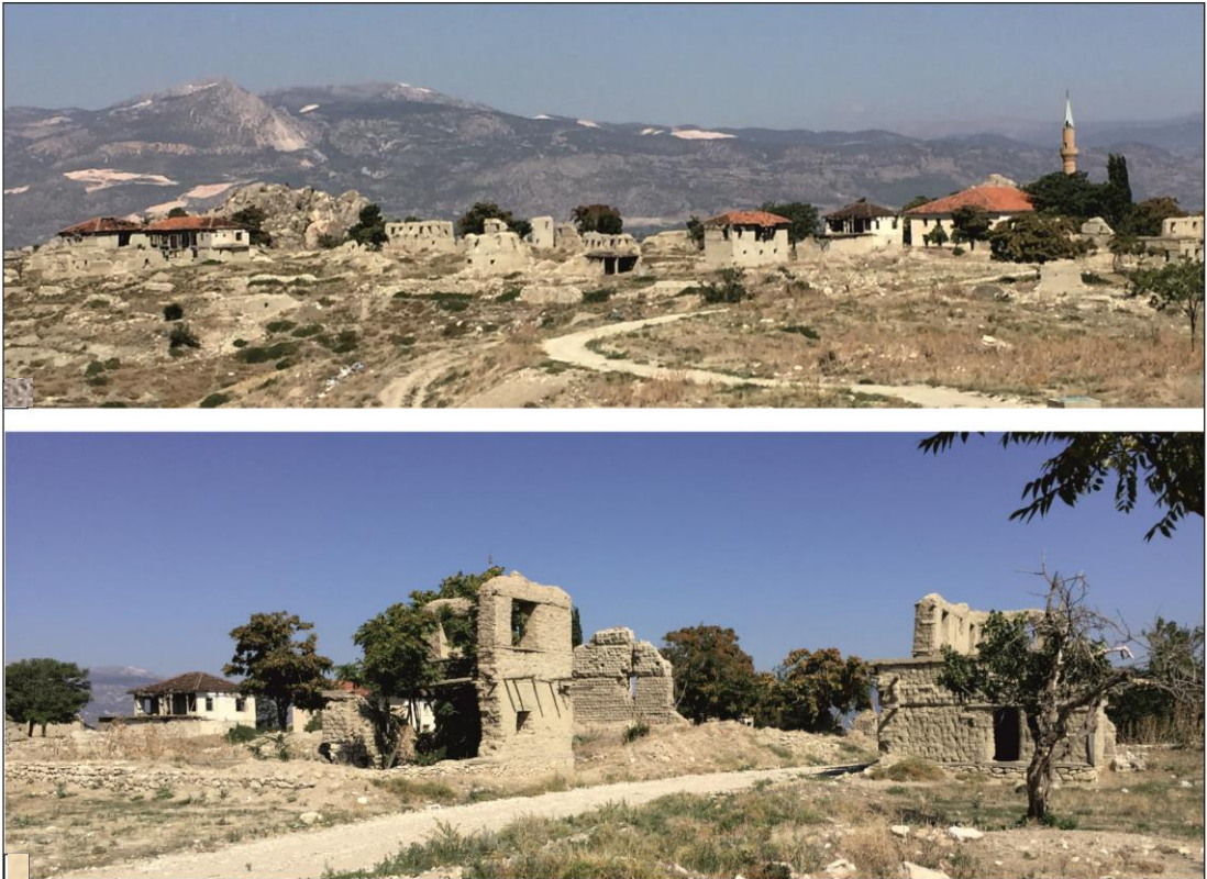
Şekil 5.3. 12 Mayıs 1971 depreminde yıkılan ve boşaltılan Yassıgüme köyünün günümüzdeki görünümü
