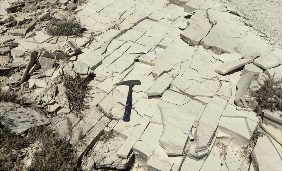
Şekil 3.25. Burdur formasyonu içinde gelişmiş çatlak sistemleri
