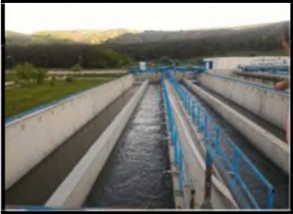
4. Havalandırmalı Kum ve yağ Tutucu Yapısı
