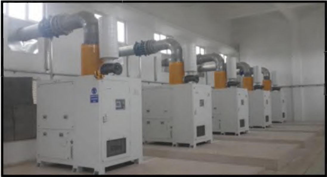
Şekil 4.5. Havalandırma Ekipmanı Neuros NX350-C070 (Anonim, 2015).
