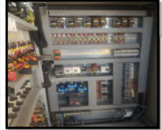
12. Trafo ve Jenaratör Binası
