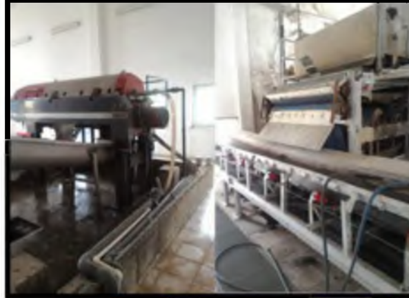
11. Çamur Susuzlaştırma Yapısı
