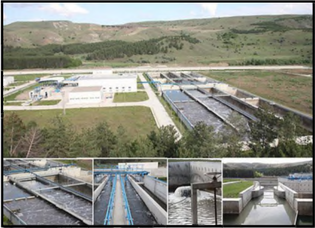
Şekil 3.1. Karaköy Atıksu Arıtma Tesisi.
