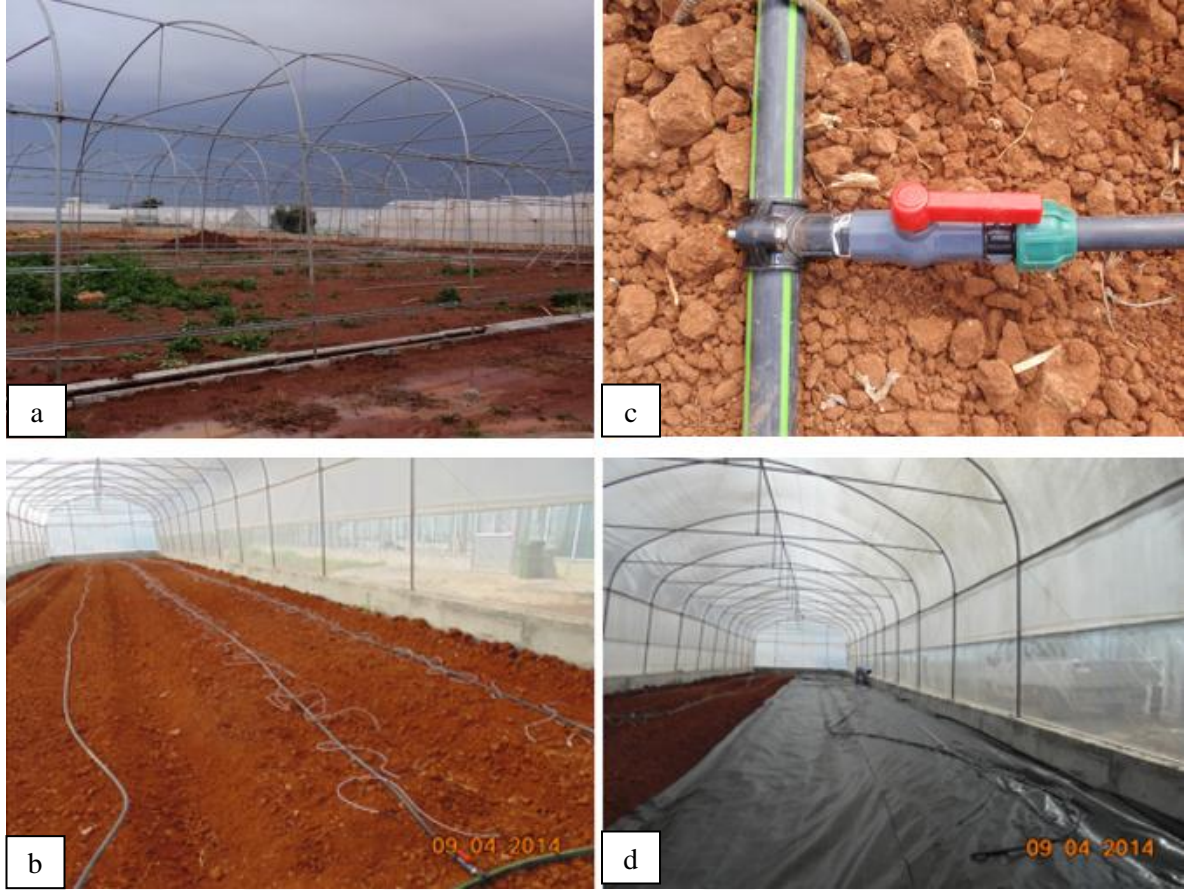
Şekil 3.1 Deneme yapılan yay çatılı PE örtülü seraların kuruluş ve deneme alanlarının düzenlenme aşamaları
