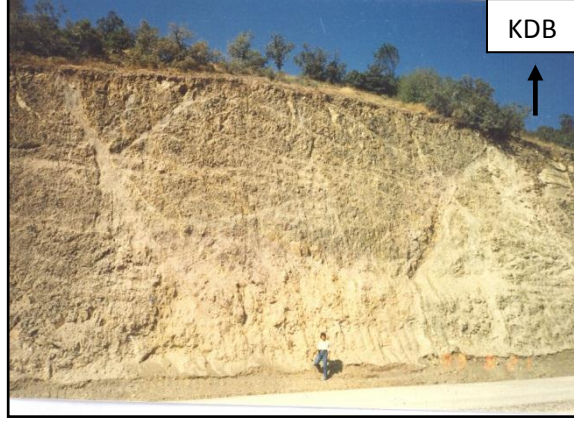
Şekil 6.22 Volkanik kayalarda sık gözlenen tali fayların Kızılcahamam Güvem yeni yol yarmasındaki görünümü
