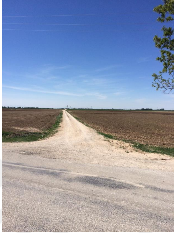
Şekil 4.1.Toplulaştırma Sonrası Yol
