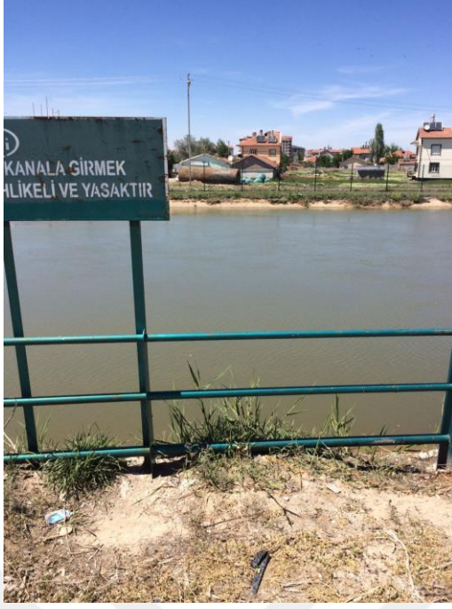
Şekil 4.2. Ana Sulama Kanalı
