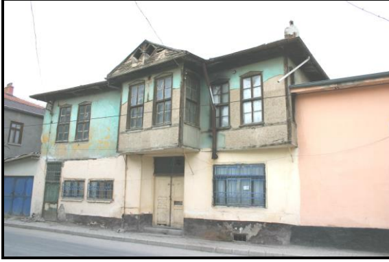
Resim 99. Giriş Cephesi Restorasyon Öncesi 2009 (KUDEB)
