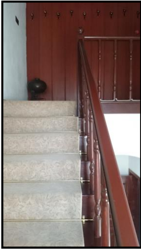
Resim 39. Merdivenler Restorasyon Sonrası
