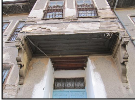
Resim 66. Giriş Cumbası Restorasyon Öncesi (KUDEB)
