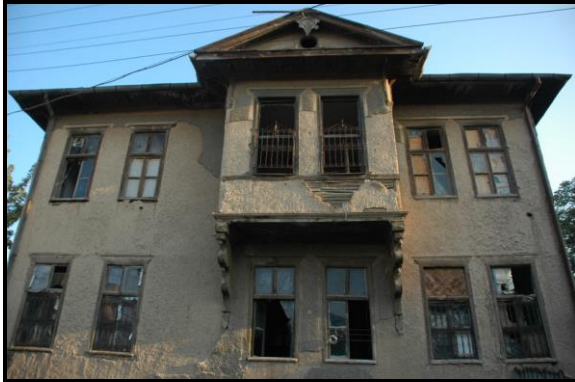
Resim 29. Kuzey Cephe, Restorasyon Öncesi 2009 (Konya Büyükşehir Belediyesi KUDEB)
