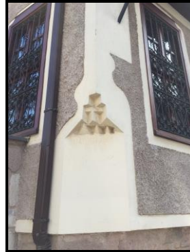
Resim 63. Cepenin Köşesinde Tuğla Süsleme Restorasyon Sonrası
