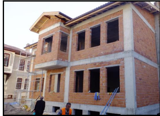
Resim 89. Yeniden Betonarme Yapım Aşaması (KUDEB)
