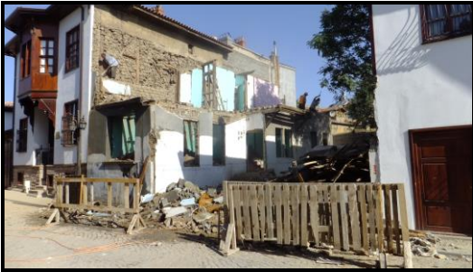
Resim 87. Restorasyon Öncesi Yıkım Aşaması (KUDEB)
