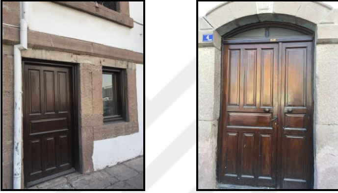
Resim 26. Sırasıyla Batı ve Kuzey Cephe Kapıları
