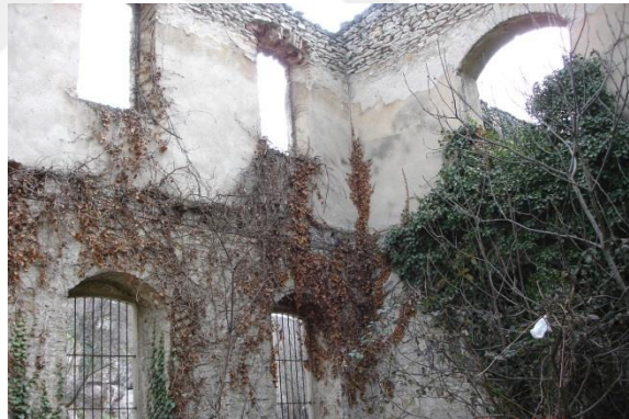
Şekil 4. Tabakhane Binası İç Mekan
