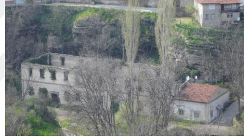
Resim 65. Tabakhane Binasının günümüze ait genel bakış
