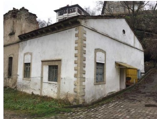
Şekil 6. Tabakhane Binası Sağ Cephe
