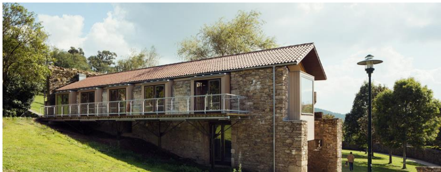
Resim 24. Güney Cephe (Frearson, 2016)
