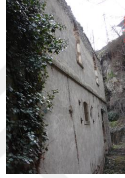
Resim 71. Tabakhane Binası Sol Cephe
