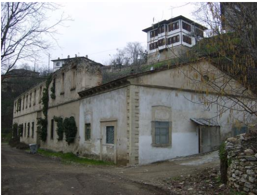
Resim 74. Tabakhane Binası Genel Görünüm
