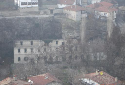
Resim 72. Tabakhane Binası Genel Görünüm
