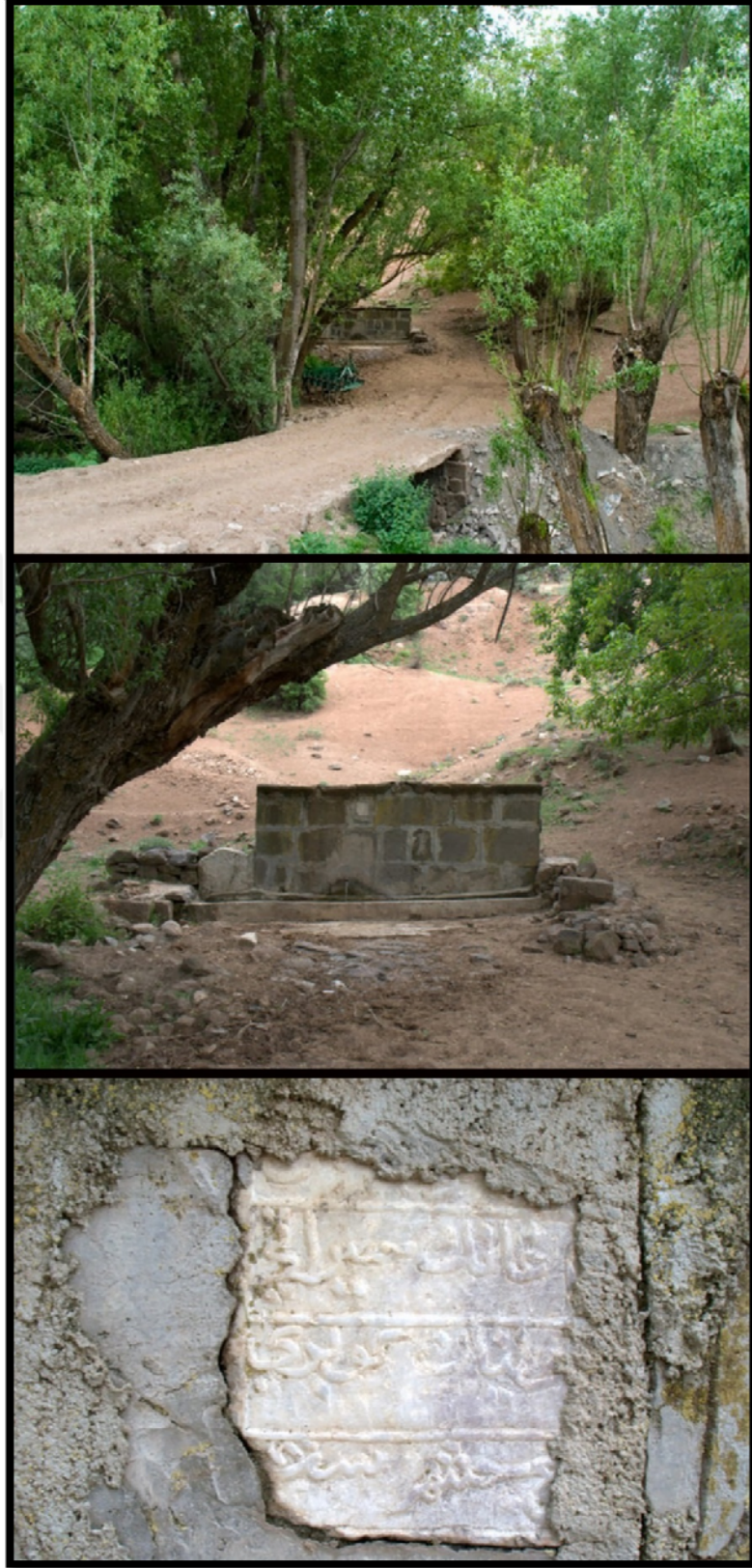
Şekil 4.3 Evciler Mahallesi'nde bulunan kitabeli Üçağaç Çeşmesi (Anonim, 2015c)
