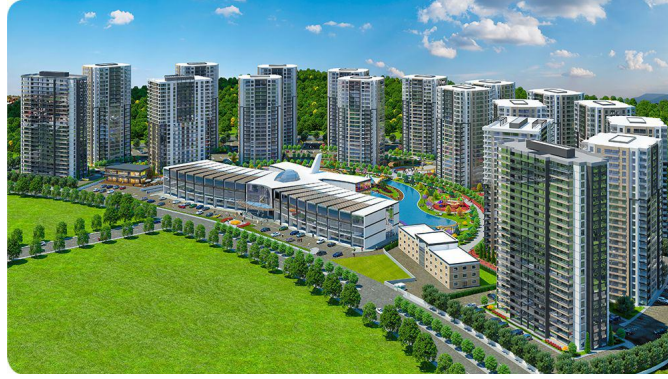
Şekil 2.8. Son yıllarda yapılan kompleks konut projesi örneği (URL 8).
