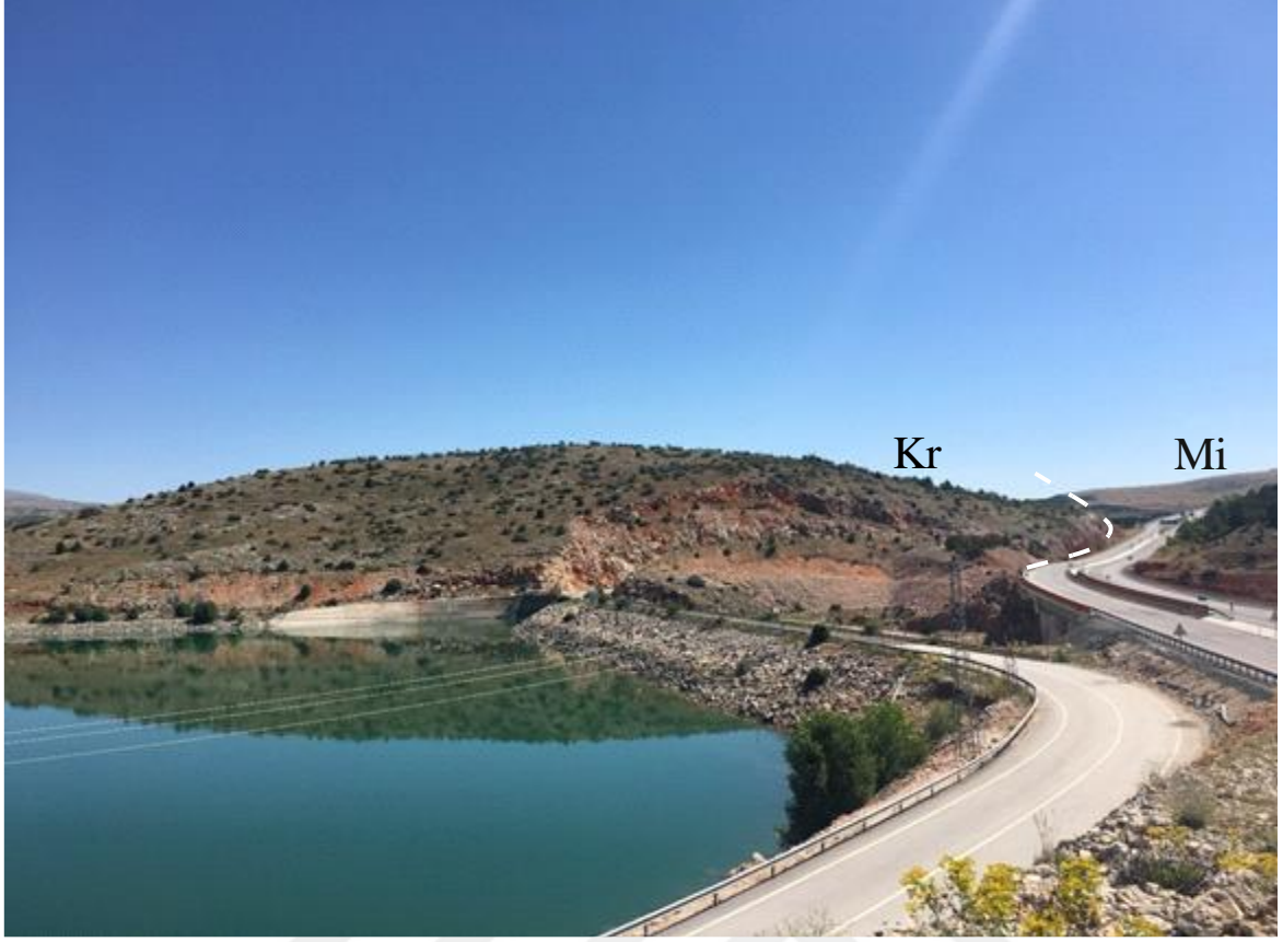
Şekil 4.1 İnceleme alanının genel görünümü
