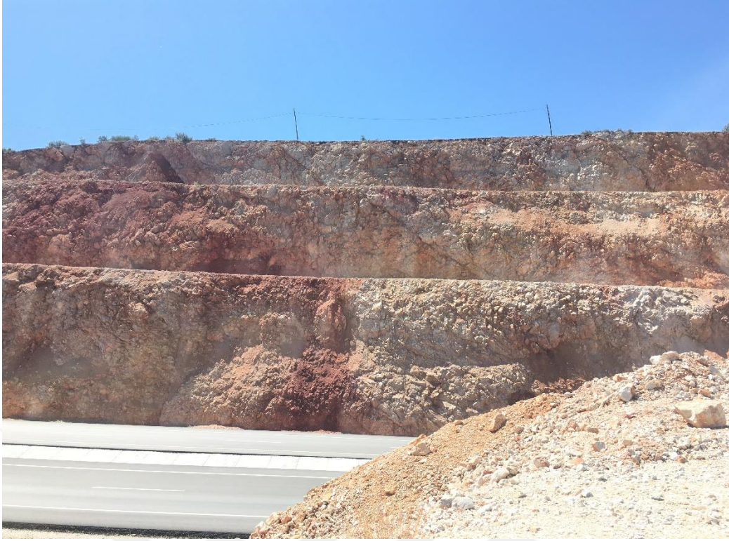
Şekil 4.5 Oluşumu tamamen tektonik kontrollü ve suyun hareketi ile alakalı ayrışmalara bağlı olarak Lorasdağı kireçtaşlarının çok kırıklı fay zonlarında ortaya çıkan kırmızımsı-kahverenkli terra rossa oluşumları
