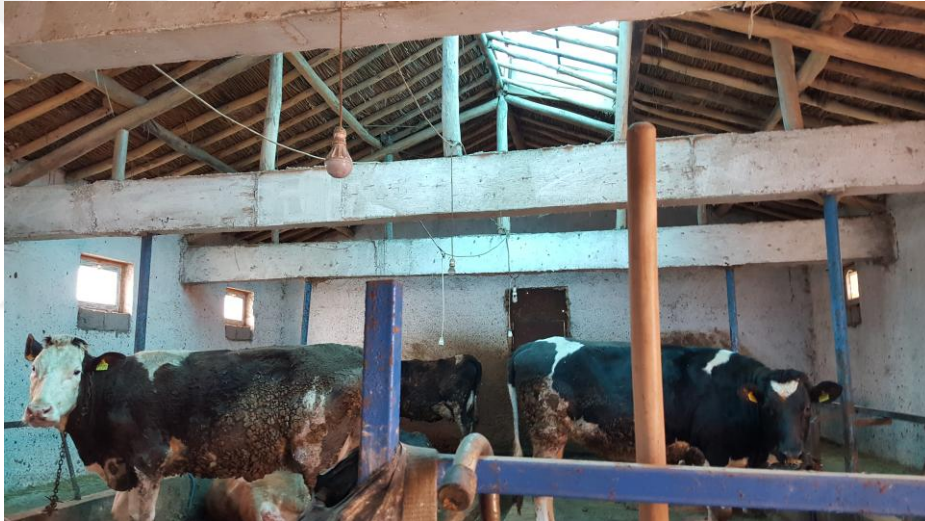
Şekil 4. 6. Araştırmada incelenen süt sığırı işletmesindeki 2 nolu bağlı duraklı barınak çatısından görünüm
