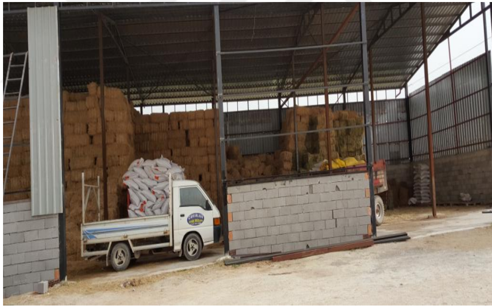
řekil 4. 9. Arařtırmada incelenen 19 nolu serbest sitem barınaklardaki st sığırı iřletmesinin yem deposu grnm.
