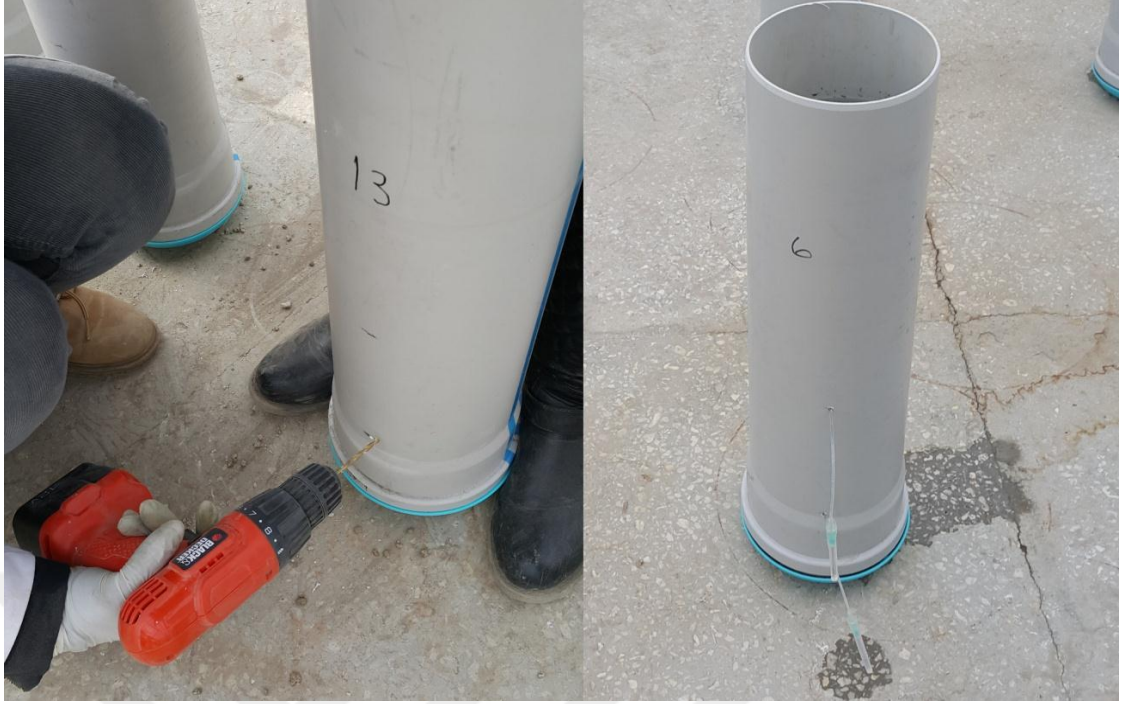
Şekil 3.3 PVC kolonların delinerek nem örnekleyicilerin yerleştirilmesi
