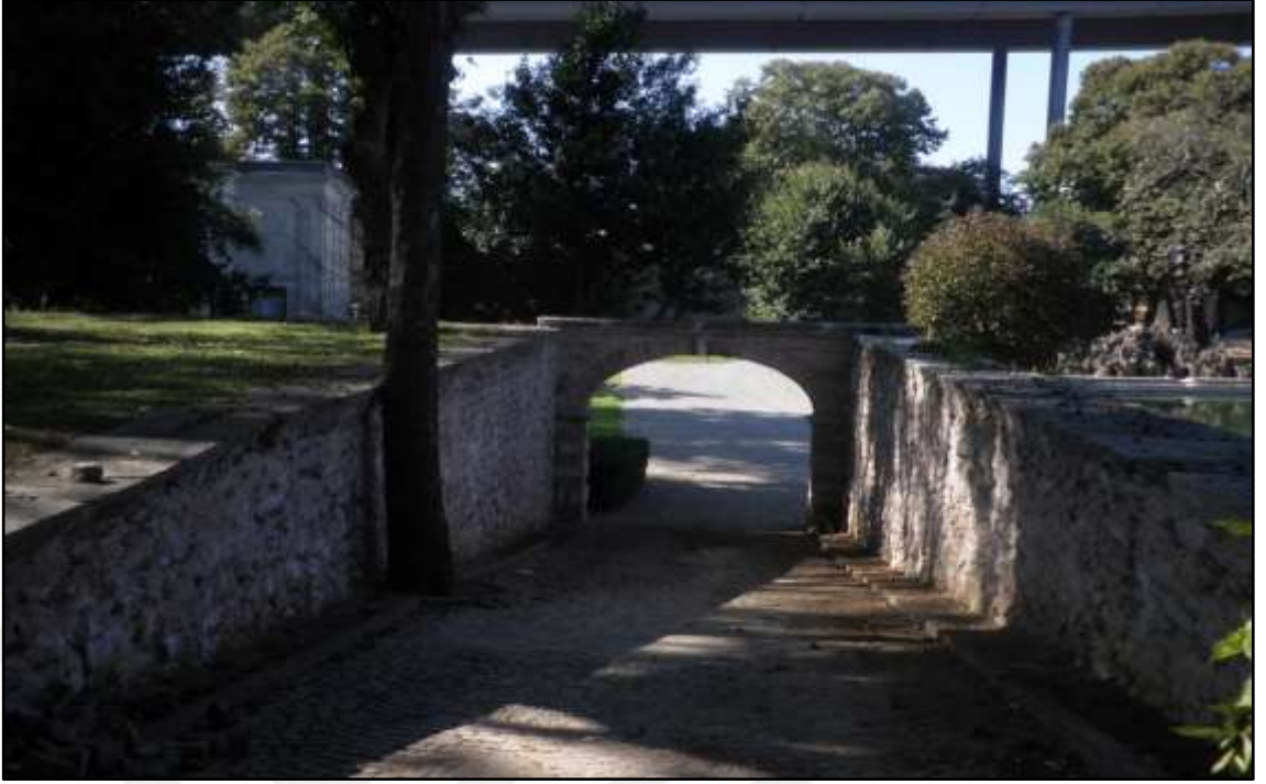
Şekil 4. 163 Sarı Köşk'ü Mermer Köşk'e bağlayan rampanın zemin kaplamasında küp taş kullanımı (Orijinal 2012)
