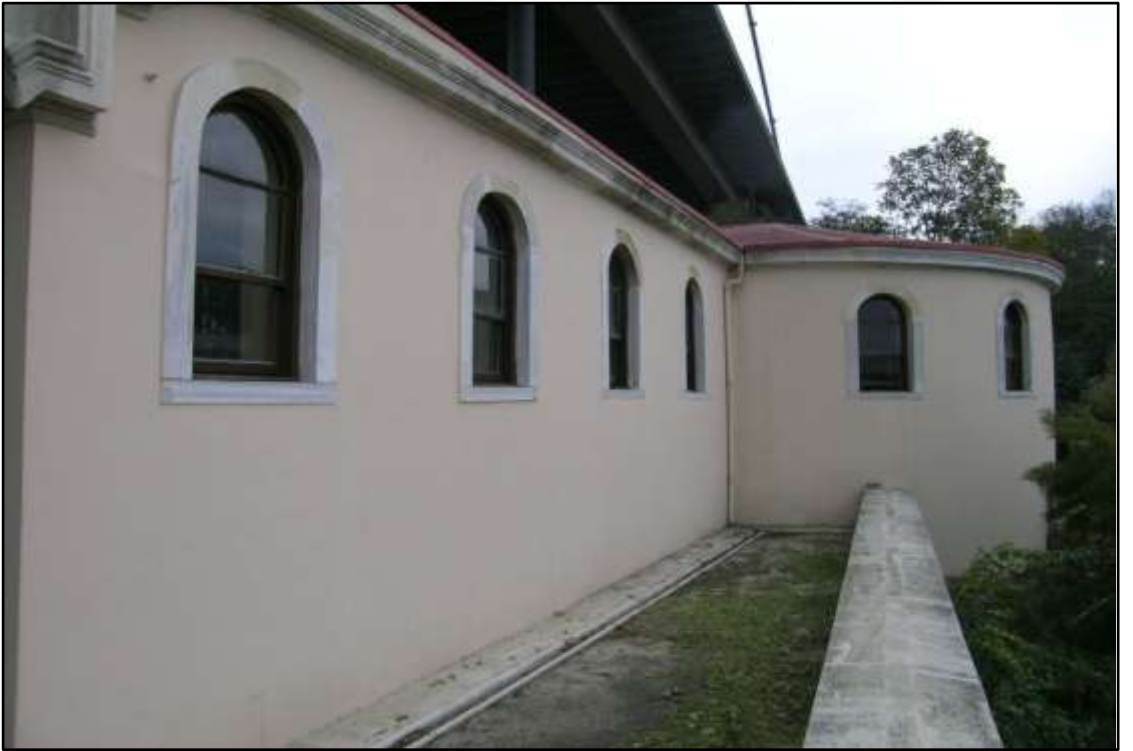
Şekil 4.36 Ahır Köşk, güney cephesi (Dündar 2008)
