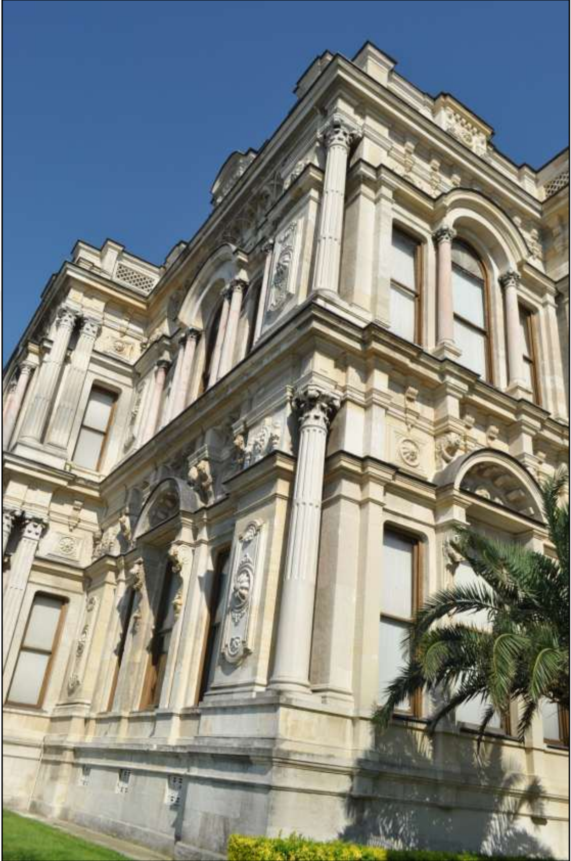
Şekil 4.20 Saray yapısının köşelerinde yer alan gömme kolonlar (Orijinal 2012)
