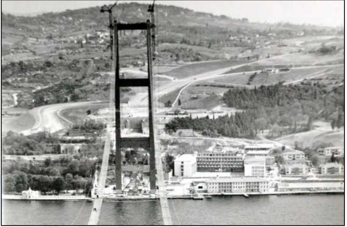
Şekil 5.4 İstanbul, Anadolu Yakası, Boğaziçi Köprüsü yapımı (Topçu 2006)
