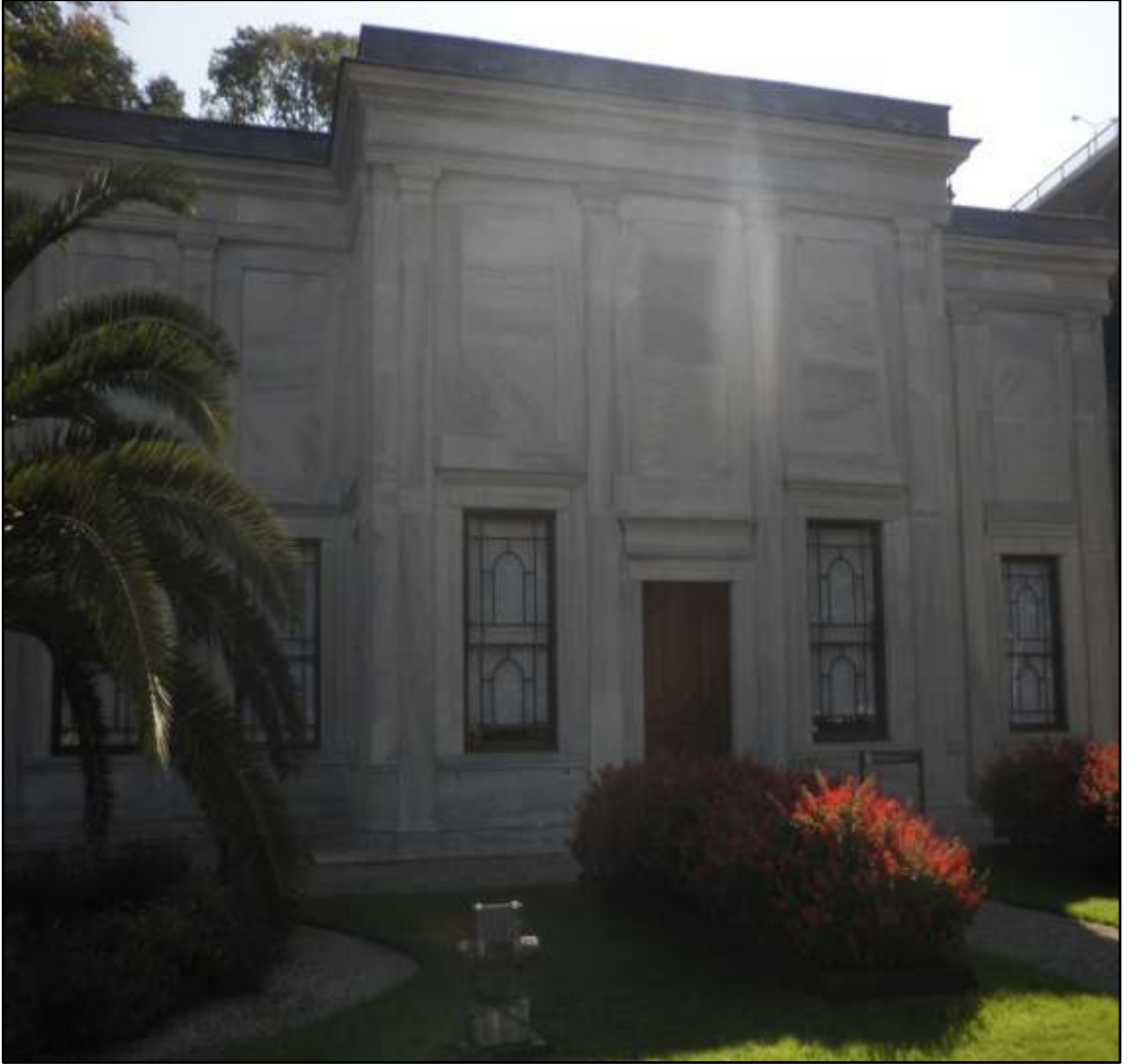
Şekil 4.10 Beylerbeyi Sarayı, Mermer Köşk, batı cephesi (Orijinal 2012)
