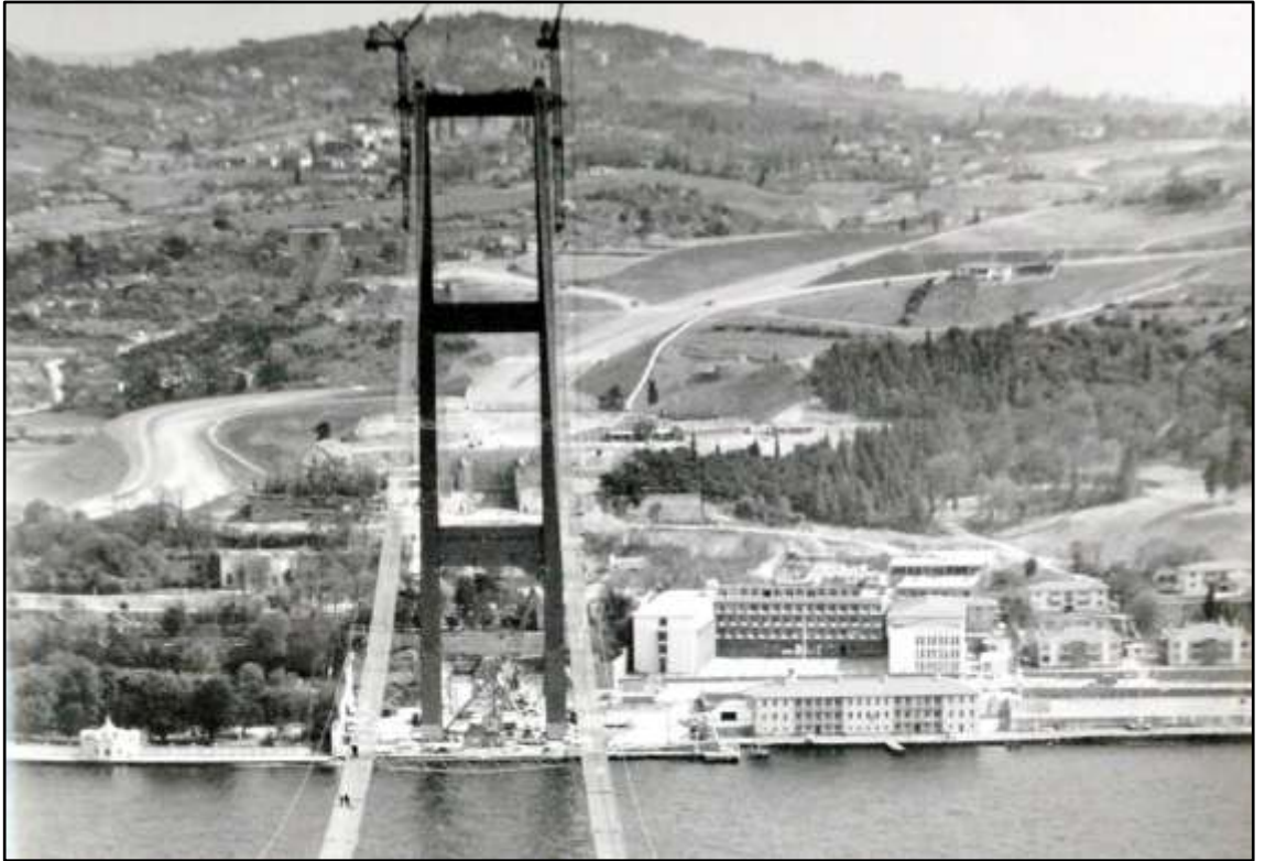
Şekil 4.50 Anadolu Yakası, Boğaziçi Köprüsü yapımı, yıl: 1973 (Topçu 2006)
