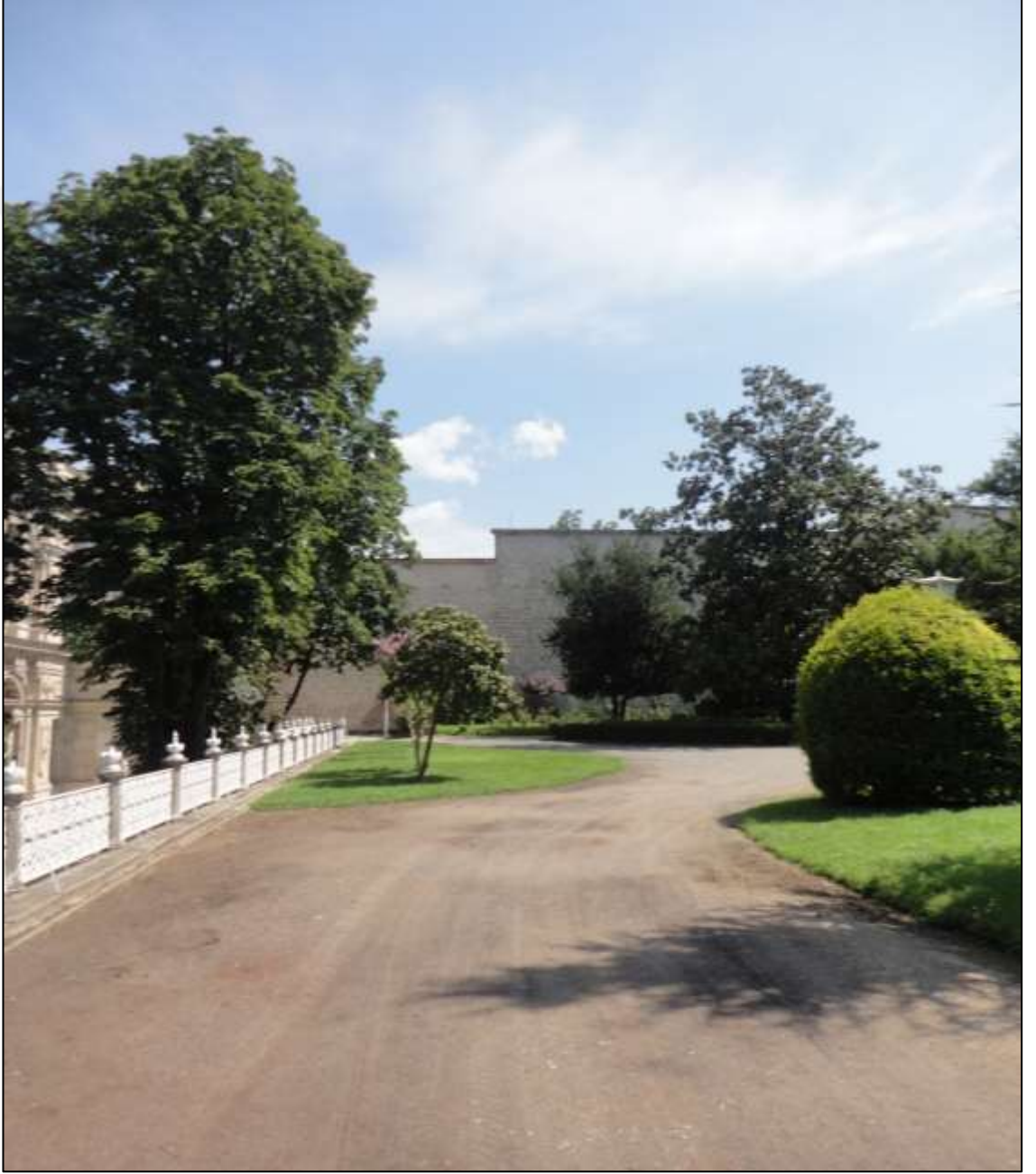
Şekil 4.157 Birinci set bahçesi, sıkıştırılmış toprak görünümlü zemin kaplaması (Orijinal 2013)
