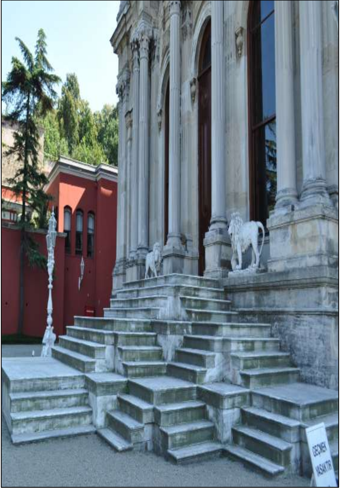
Şekil 4.17 Harem-i Hümayun, kuzey cephe girişinde yer alan merdivenler (Orijinal 2012)
