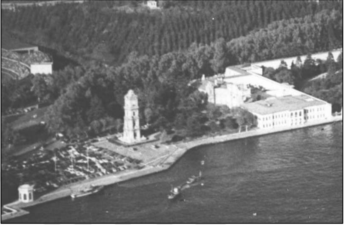
Şekil 2.58 Dolmabahçe Sarayı, 1857 yılındaki durumu (Atalay-Seçen 2011)
