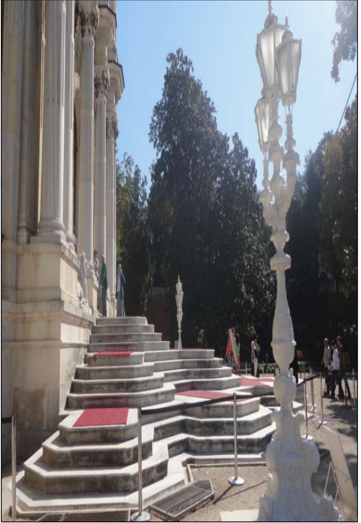
Şekil 4.18 Mabeyn-i Hümayun; güney cephe girişinde yer alan merdivenler (Orijinal 2012)
