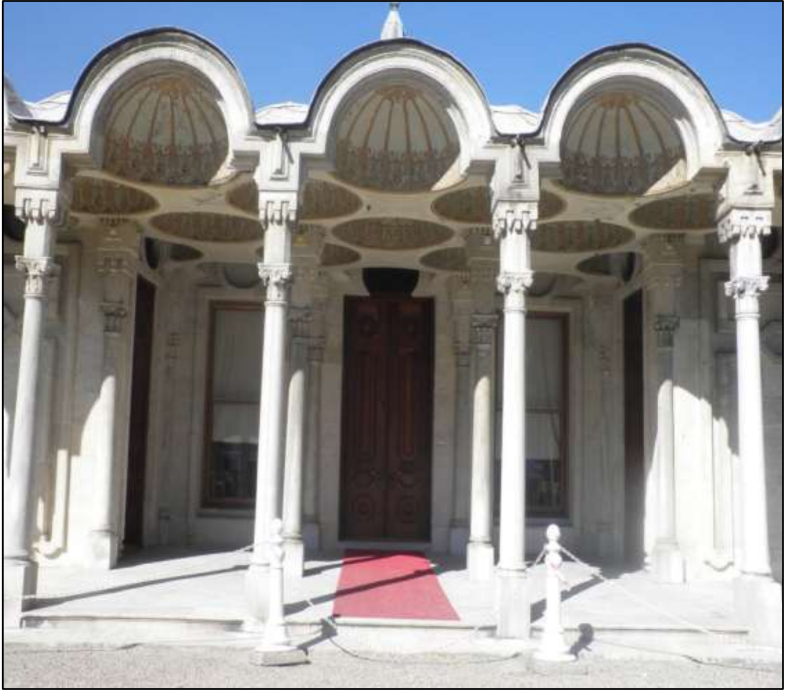
Şekil 4.22 Harem Deniz Köşkü, çok kubbeli örtü sistemi ile tasarlanmış olan revak (Orijinal 2012)
