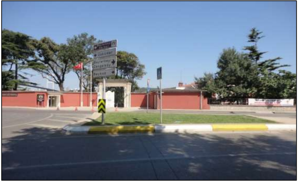
Şekil 4.106 Beylerbeyi Sarayı, harem bahçesi duvarının bugünkü durumu (Orijinal 2014)
