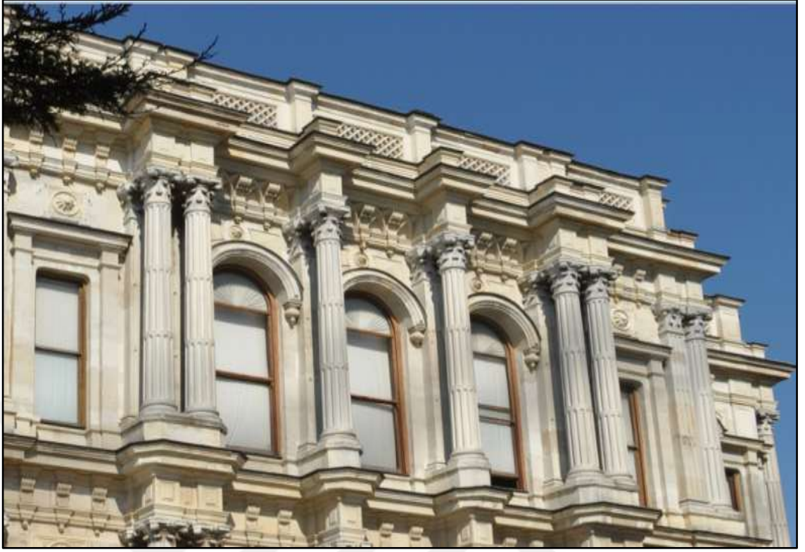
Şekil 4.15 Binanın eğimli çatı örtüsü parapet ile kısmen gizlenmiştir (Orijinal 2012)
