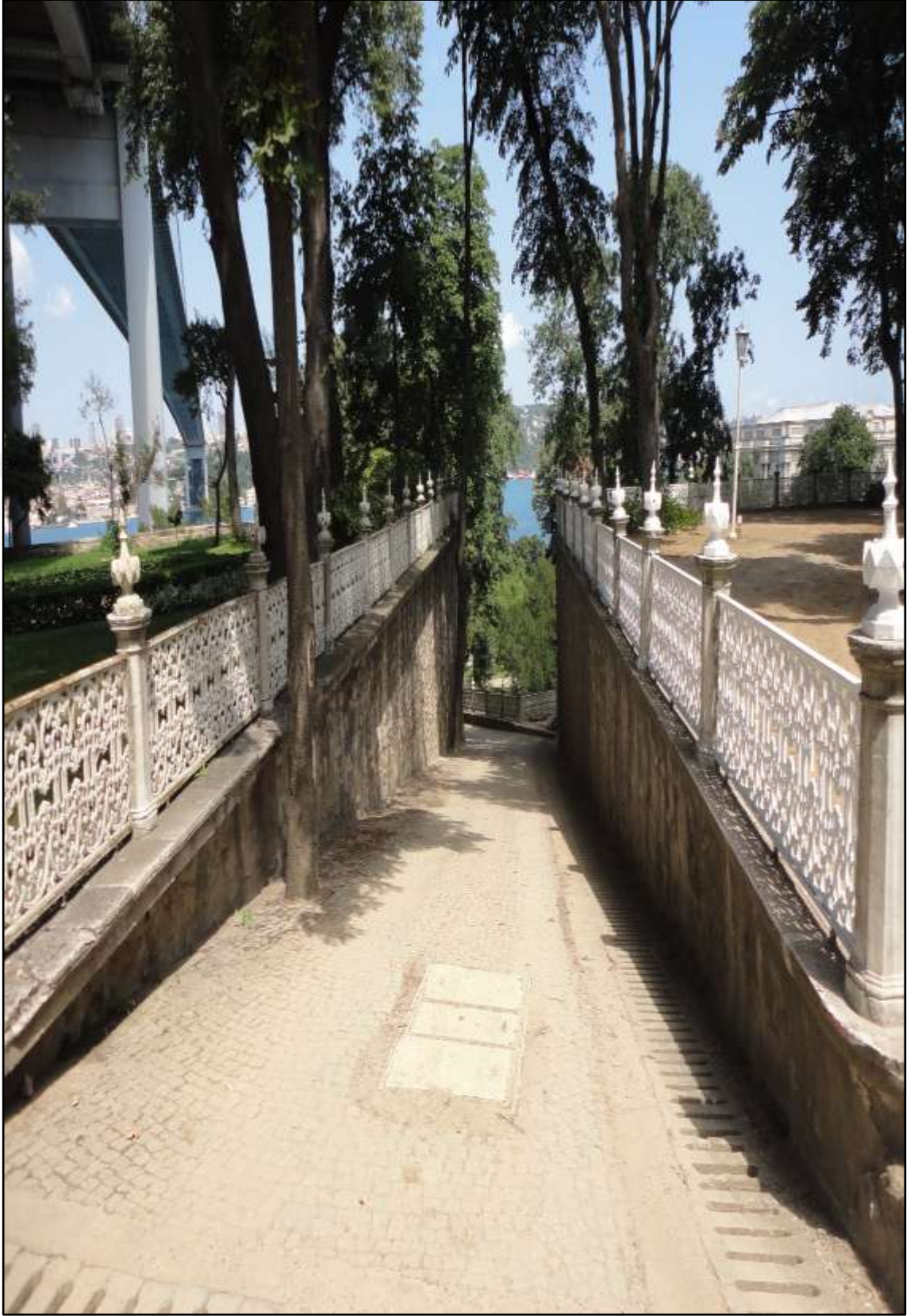
Şekil 4.80 Selamlık bahçesini dördüncü sete bağlayan rampanın zemin kaplamasında küp taş kullanımı (Orijinal 2013)
