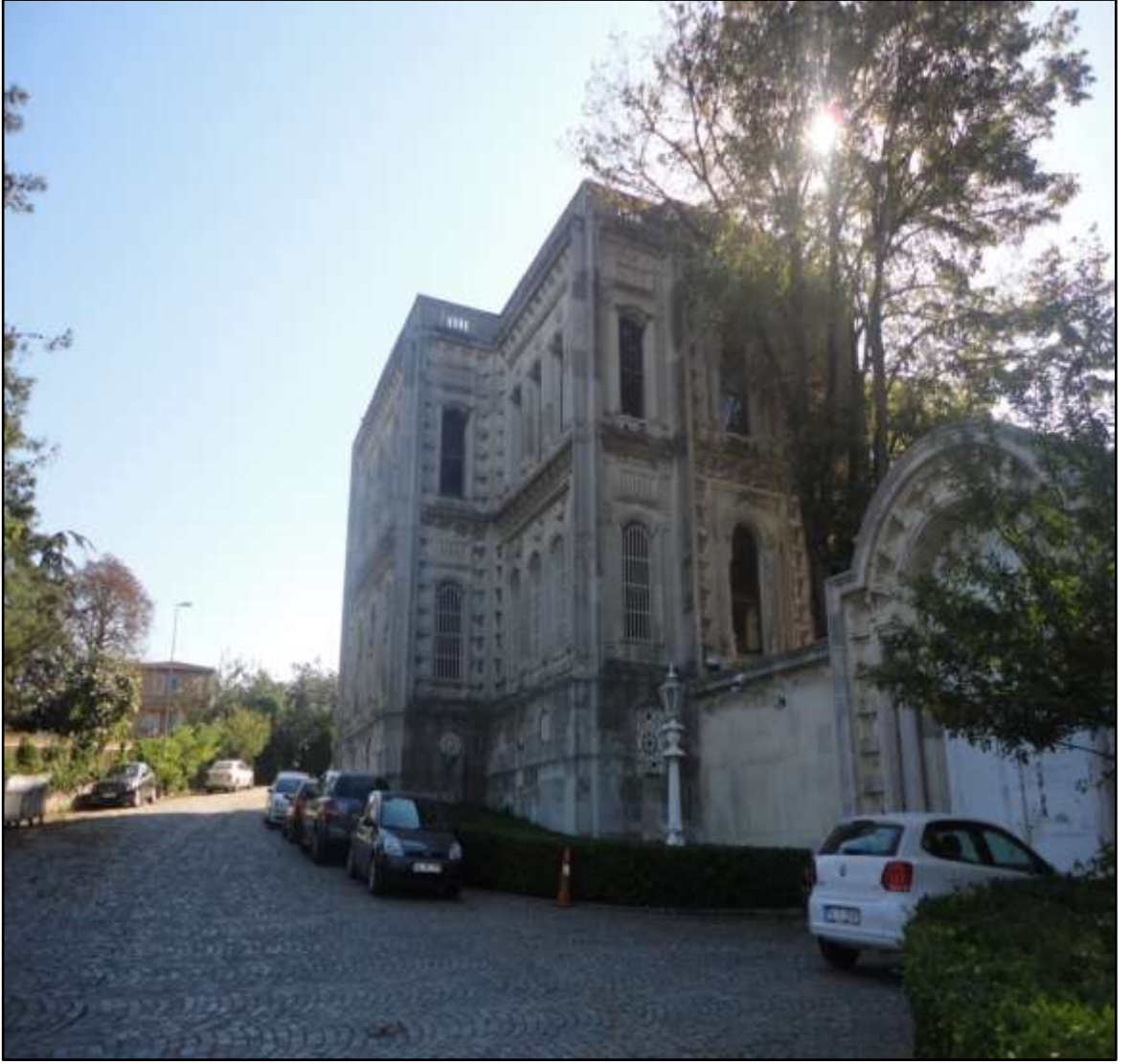
Şekil 4.27 Sarı Köşk, güney cephesi (Orijinal 2012)
