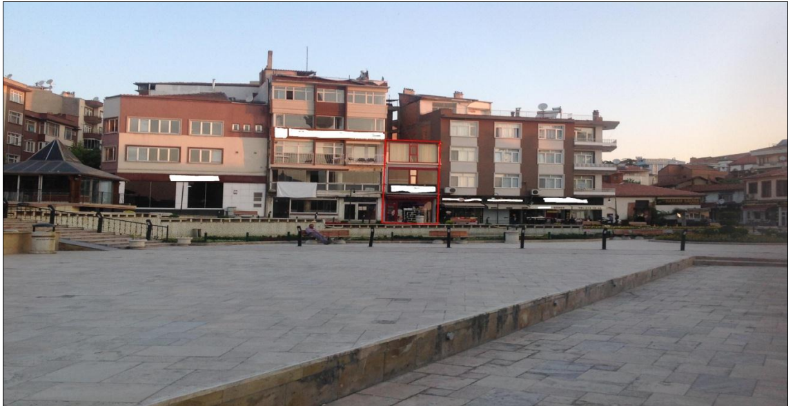
Şekil 4.24 396 ada ve 5 parselde bulunan yapının görünümü
