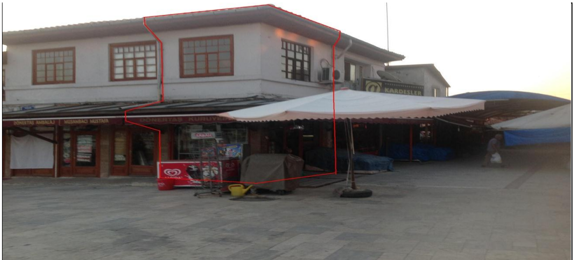
Şekil 4.22 217 ada ve 26 parselde bulunan yapının görünümü
