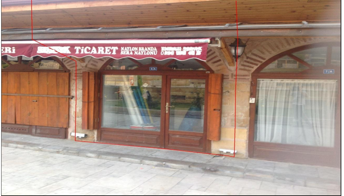
Şekil 4.25 199 ada ve 29 parselde bulunan yapının görünümü
