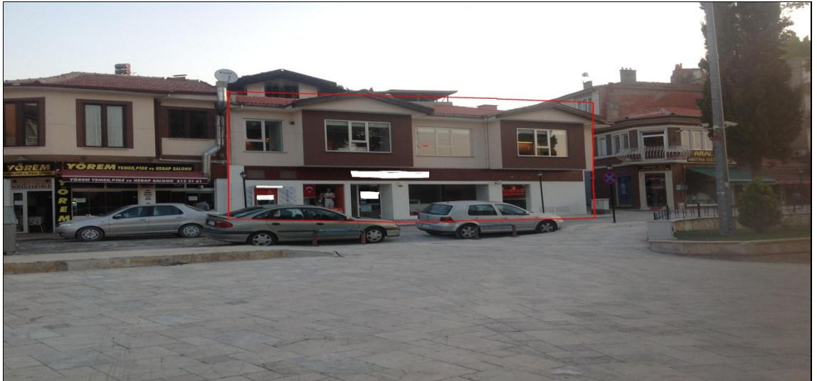
Şekil 4.23 395 ada ve 13 parselde bulunan yapının görünümü
