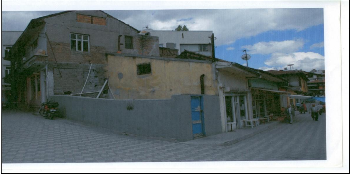
Şekil 4.7 238 adada bulunan taşınmazların Paşa Camii Sokak tarafından görüntüsü
