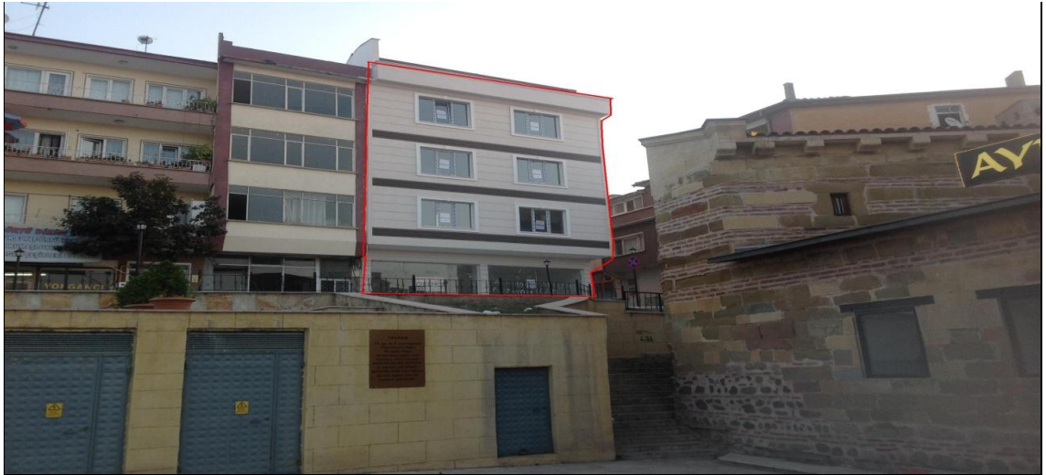
Şekil 4.27 393 ada ve 19 parselde bulunan yapının görünümü
