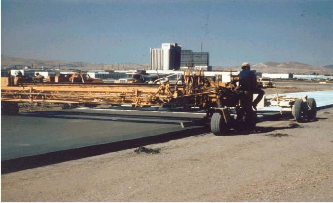
Şekil 2. 9 Beton yol yapımı
