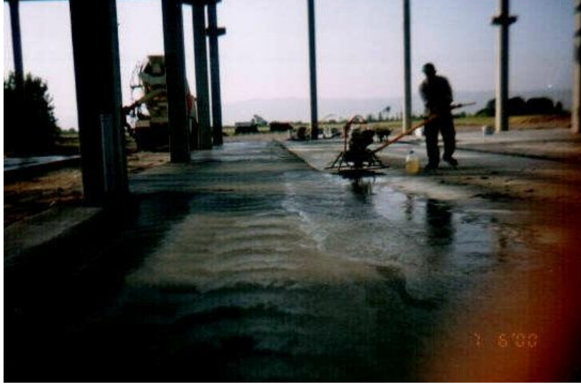
Şekil 2. 8. Fabrika sahası betonlarında Lifli beton kullanımı
