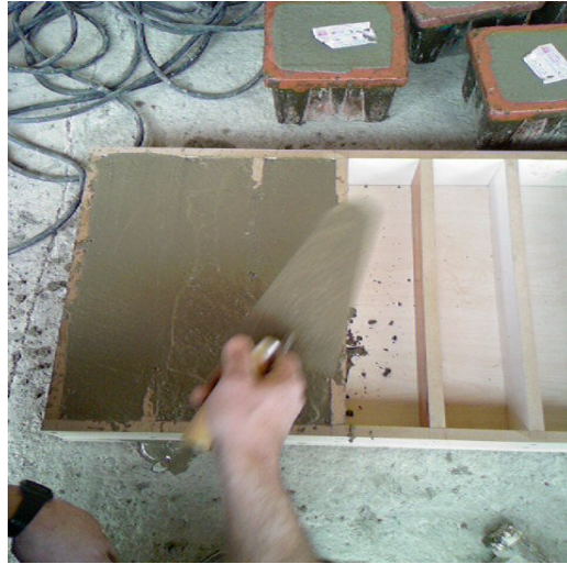
Şekil 3. 7. Betonun kalıplara yerleştirilmesi ve düzeltilmesi
