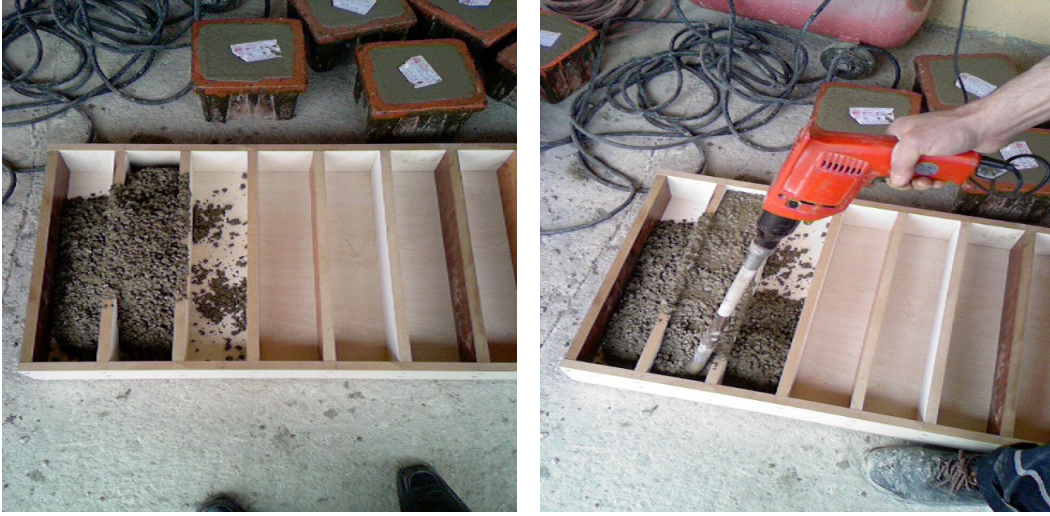
Şekil 3. 6. Kalıplara betonun dökülmesi ve vibrasyon uygulanması
