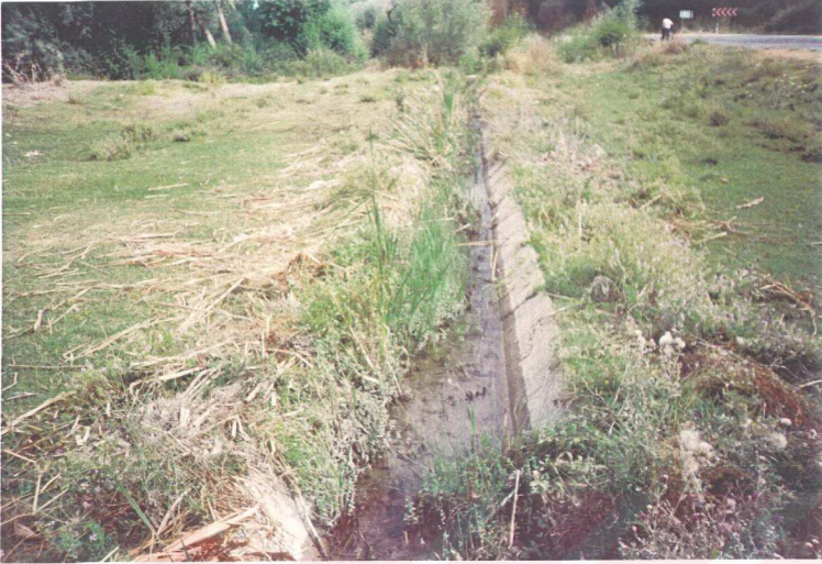
Resim 3.19. Sulama kanaleti
