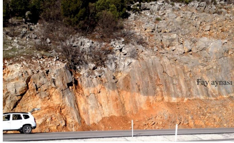
Şekil 4.19 Çataloluk formasyonu kireçtaşlarında fay aynası (Susuzayla mevki, fotoğrafta B'ya bakılmaktadır)
