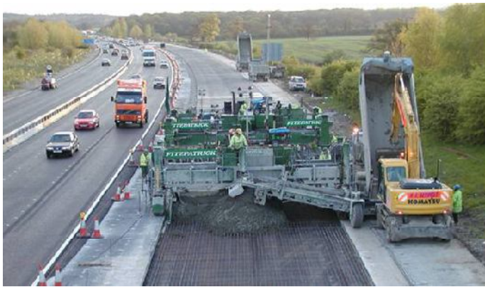
Şekil 3.11. Beton dökümü
