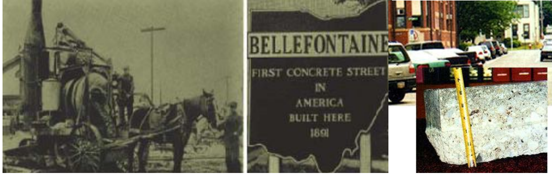
Şekil 3.1. Ohio’da bir beton yol şantiyesinin görüntüsü ve hala kullanılan beton yoldan alınan karot numunesi [22]
