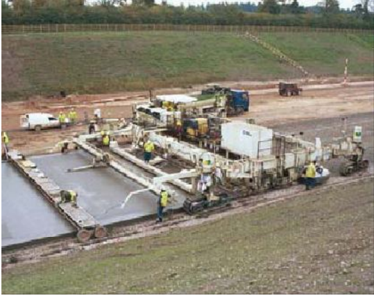
Şekil 3.17. Beton yüzeyinin düzlenmesi
