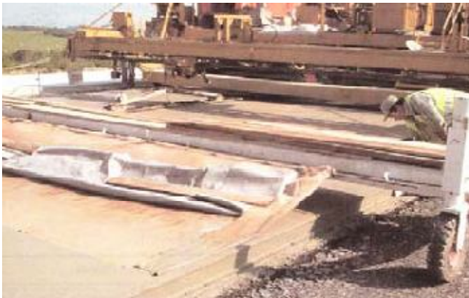
Şekil 3.19. Çuval ile pürüzleme
