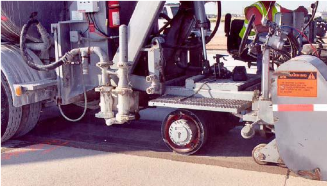
Şekil 3.22. Yol üzerinde yivler meydana getirilmesi (tining)
