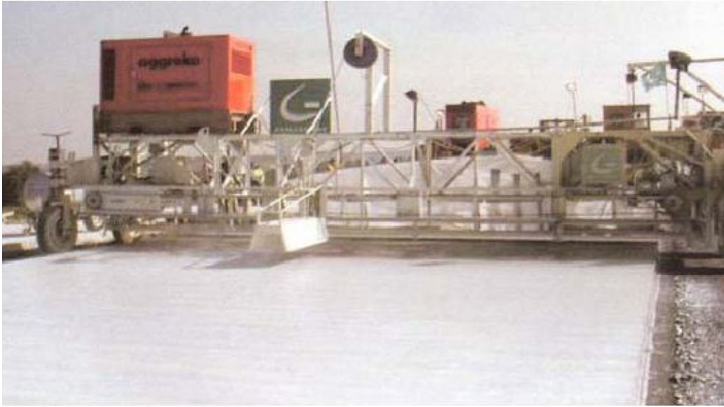
Şekil 3.27. Makine ile kür işlemi
