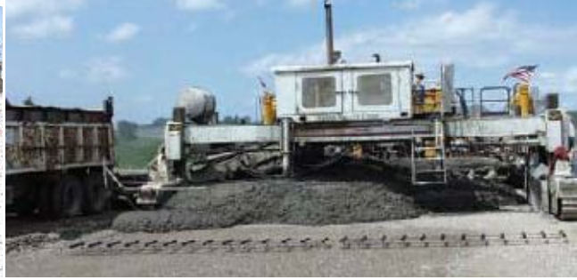
Şekil 3.15. Kayma demirleri üzerine beton dökümü
