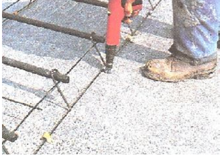
Şekil 3.14. Kayma demiri montajı
