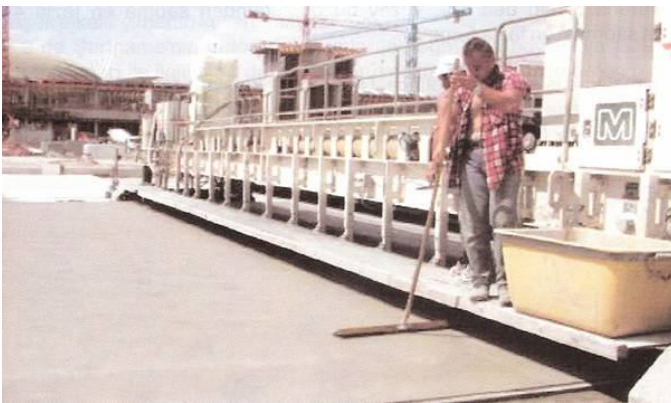
Şekil 3.20. Çelik süpürge ile pürüzleme
