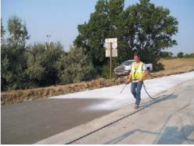
Şekil 3.26. El ile kür işlemi
