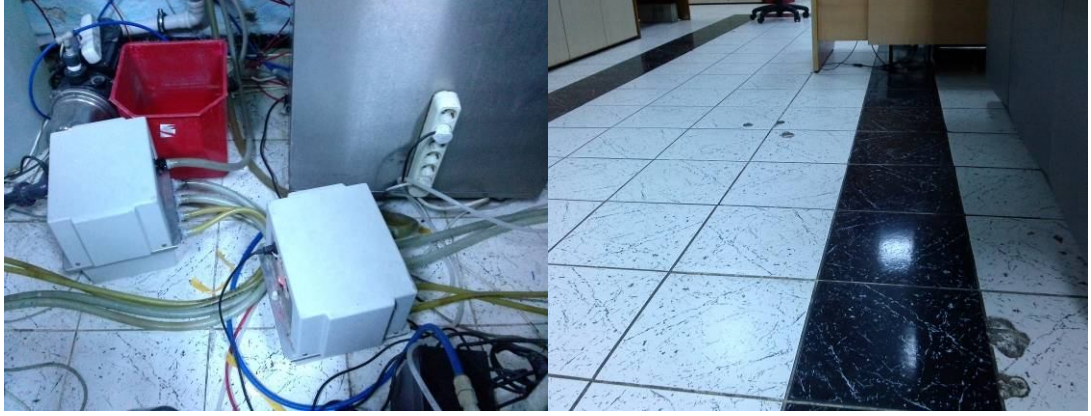
Şekil 1.10. Laboratuvarlardaki elektrik ve kaygan zemin risk faktörleri.
