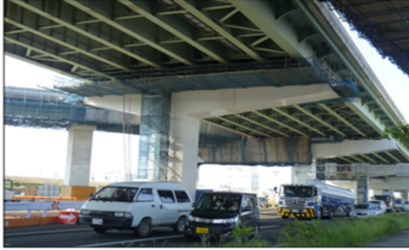
Şekil 2.22. Tek kolonlu köprü ayağı, Sendai-Tobu viyadüğü
