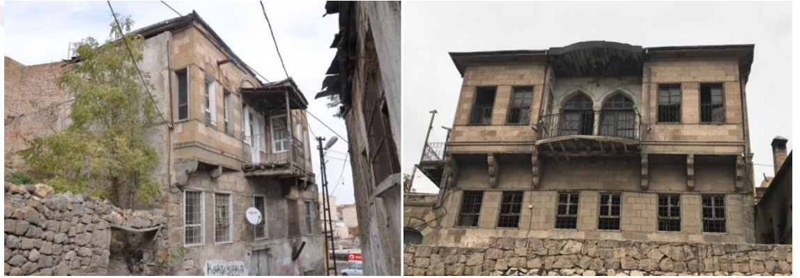
Şekil 4.67 Konut cepheleri ve avlu duvarlarındaki bakımsızlık (Orijinal 2017)
