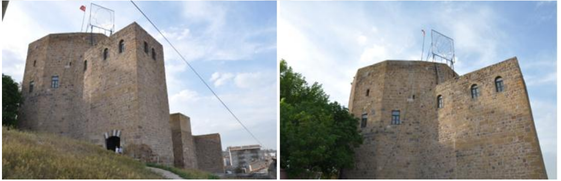
Şekil 4.29 Niğde Kalesi, güney cephe (Orijinal 2017)
