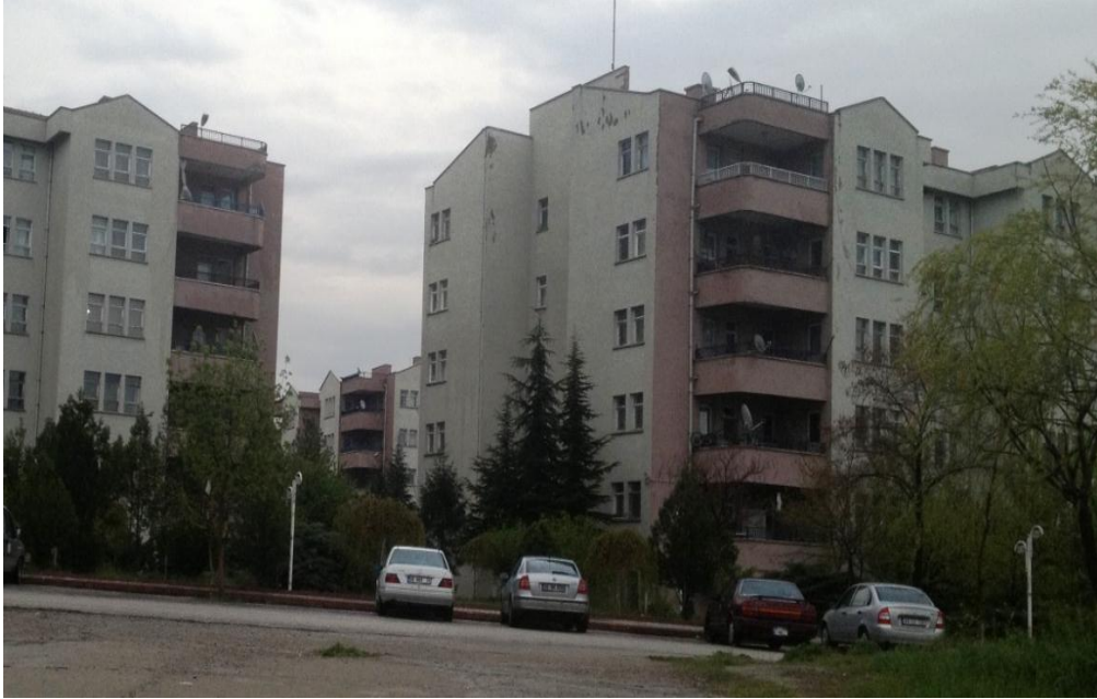
Şekil 4.88 Kira tespiti yapılacak lojmanların fiziksel görünümü
