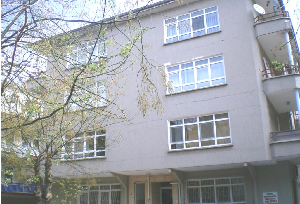
Şekil 4.45 SPK'ya ait lojmanların bulunduğu binanın fiziksel görünümü
