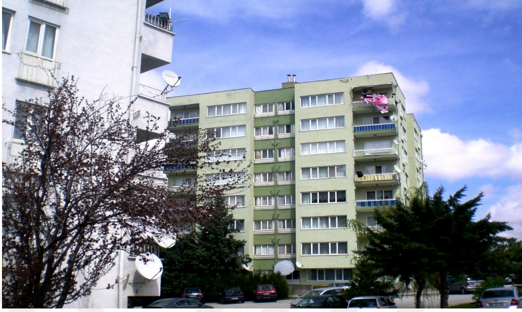
Şekil 4.36 Orman Genel Müdürlüğüne ait lojmanların bulunduğu binanın fiziksel görünümü
