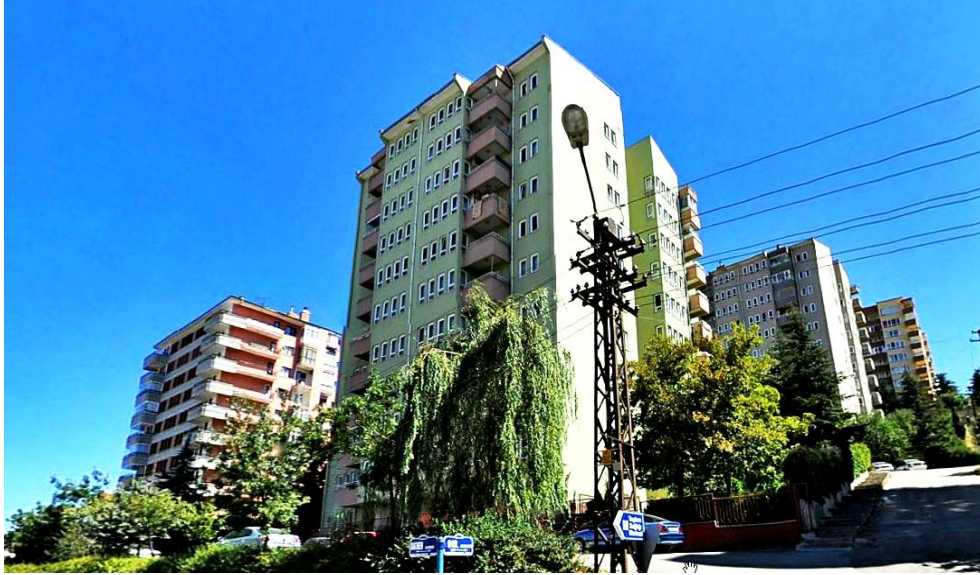
Şekil 4.11 13274 ada 3 parselde bulunan kamu konutlarının bulunduğu binanın fiziksel görünümü
