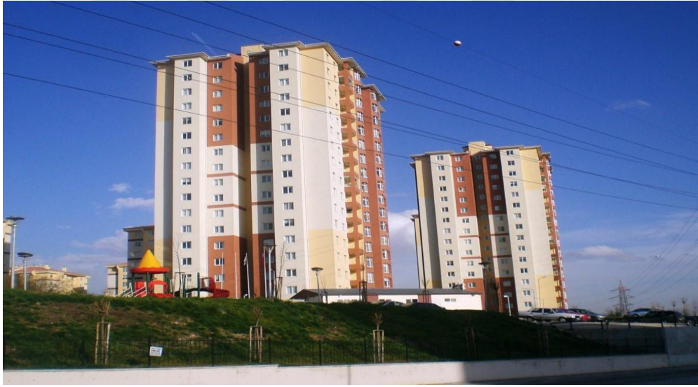
Şekil 4.89 Kira tespiti yapılacak lojmanların fiziksel görünümü
