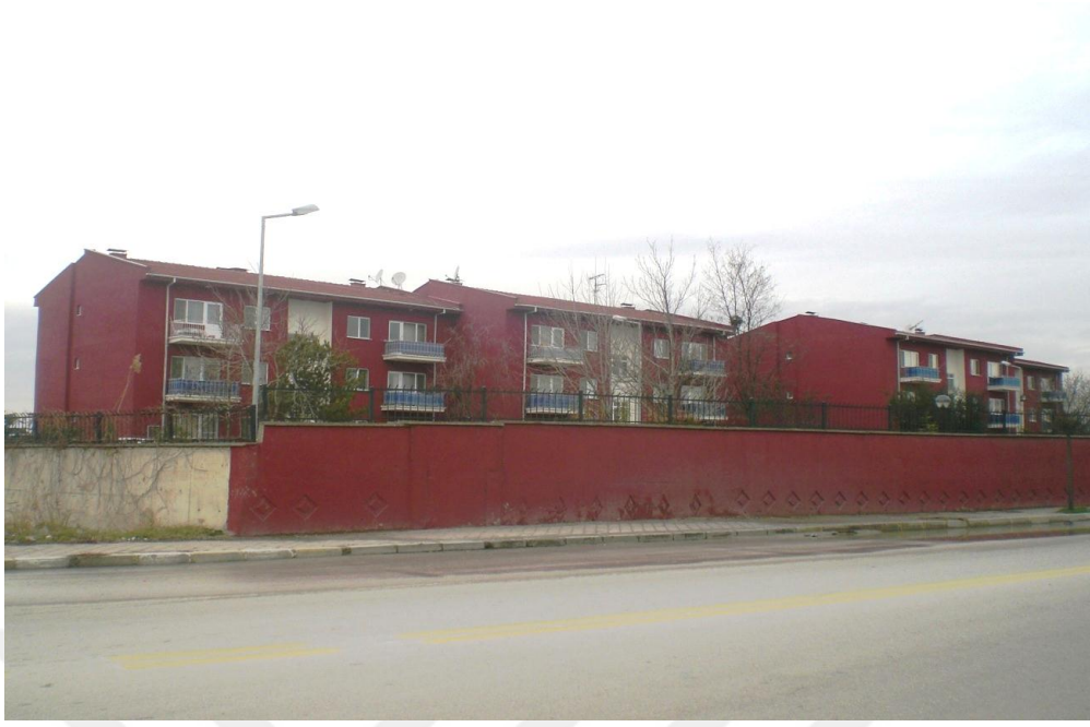
Şekil 4.65 Et ve Süt Kurumuna ait lojmanların bulunduğu binaların fiziksel görünümü
