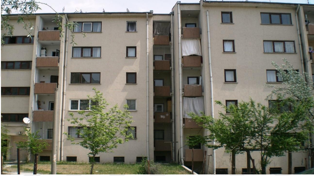
Şekil 4.100 Eryaman 4. Devlet Mahallesi’nde bulunan lojmanların fiziksel görünümü
