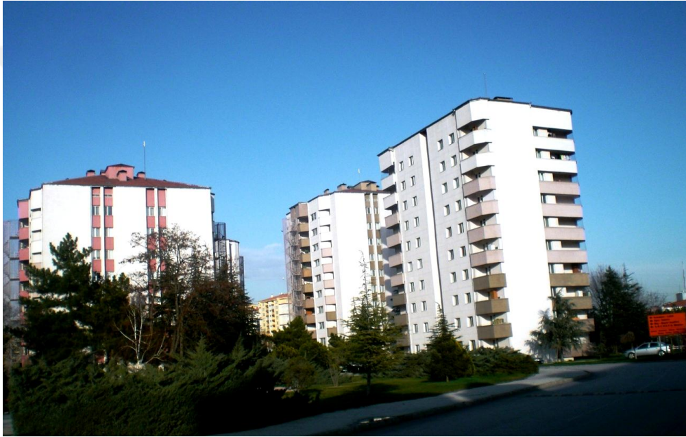
Şekil 4.31 Karayolları Genel Müdürlüğüne ait lojmanların bulunduğu binaların fiziksel görünümü
