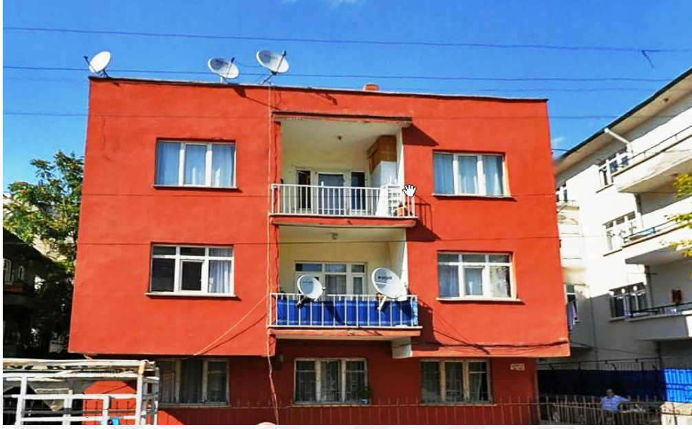
Şekil 4.98 Çankaya İncesu 8154 ada 16 parselde bulunan lojmanın fiziksel görünümü
