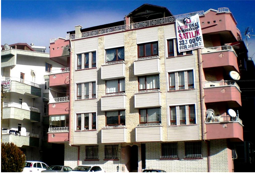
Şekil 4.21 Ankara Defterdarlığına tahsis edilmiş kamu konutunun bulunduğu binanın fiziksel görünümü
