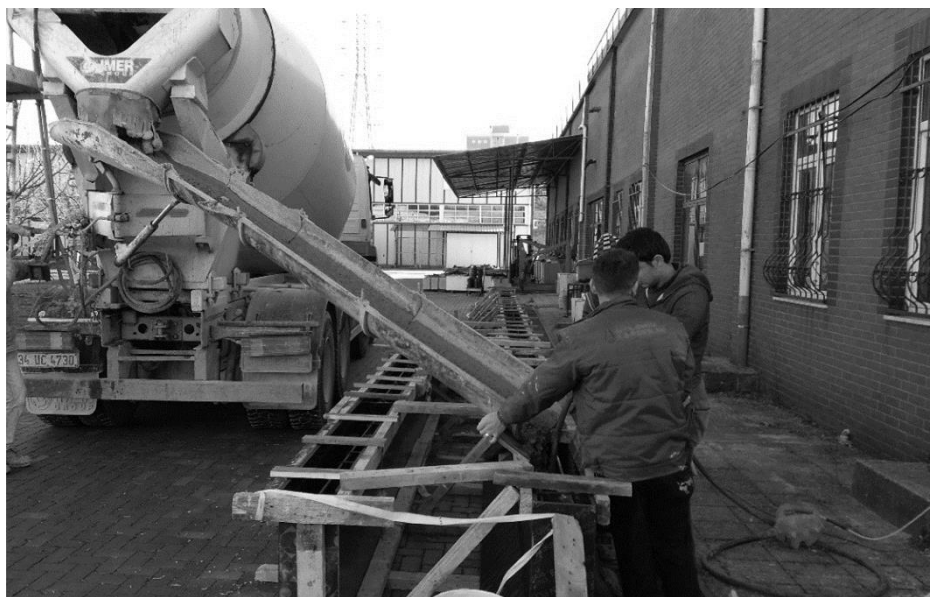
Şekil 5.13. Betonun kalıba yerleştirilmesi.
