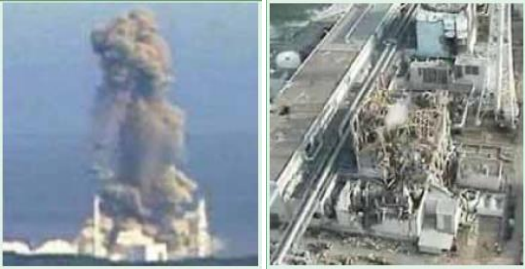
Şekil 5.2. Fukuşima genel elektrik santrali hidrojen gazı patlama anı ve sonrası [35].
