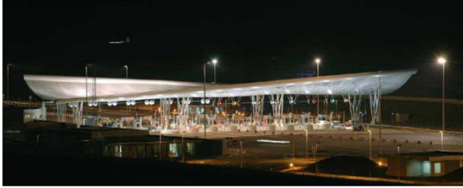
d) Çatı uygulaması
