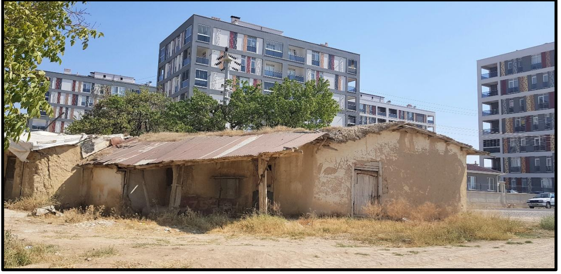
Şekil 4.12 Karaman kent merkezinde geleneksel kerpiç tarzda yapılmış kırsal konut ve modern tarzda inşa edilen toplu konutlarının bir arada verdiği görünüm (Orijinal)
