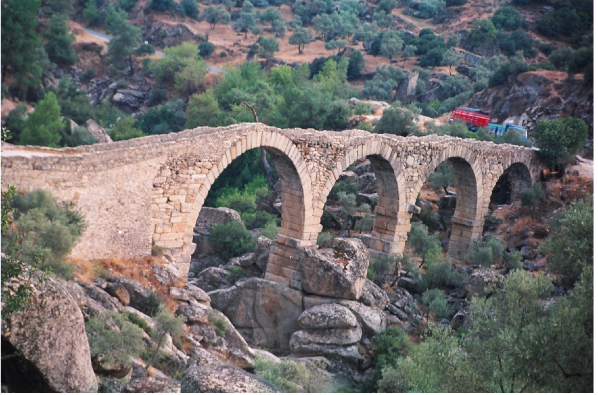
Resim 1 Gergakome'ye giden antik yol güzergahındaki İnce Kemer Köprüsü
