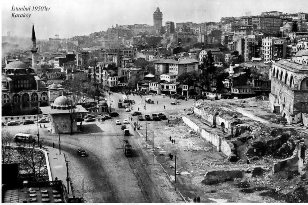
Şekil 4.38 Yıkılan kısımlar (sağda) (Anonim, 2017i)
