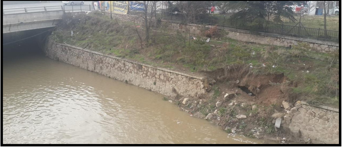
Şekil 4.15 8 numaralı noktadan mansap yönünde görünüş, Akköprü
