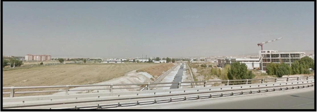
Şekil 4.10 5 numaralı noktadan mansap yönünde görünüş
