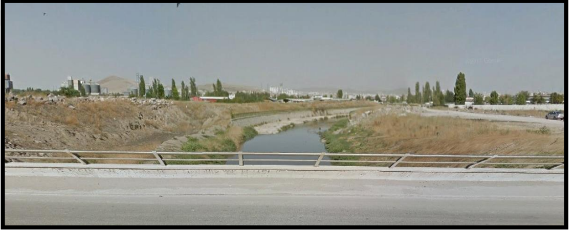
Şekil 4.7 2 numaralı noktadan memba yönünde görünüş, akarsuyun kanal içine alındığı nokta
