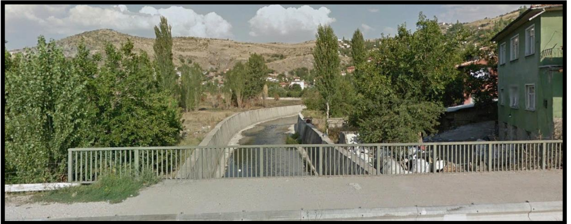
Şekil 4.23 13 numaralı noktadan mansap yönünde görünüş
