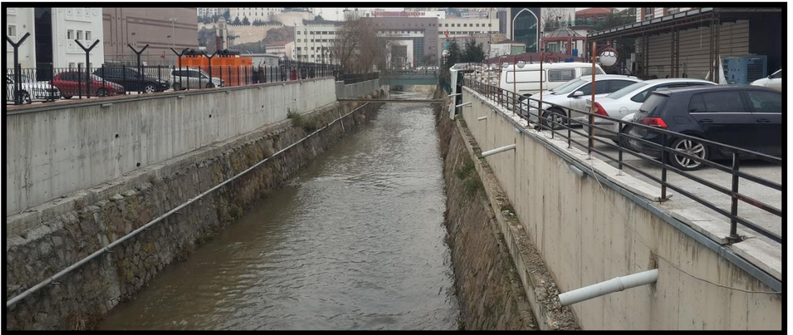
Şekil 4.17 9 numaralı noktadan memba yönünde görünüş, Keçiören Belediyesi
