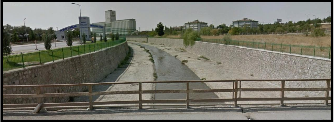
Şekil 4.11 6 numaralı noktadan mansap yönünde görünüş
