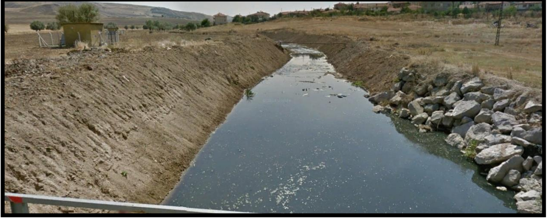
Şekil 4.27 17 numaralı noktadan mansap yönünde görünüş
