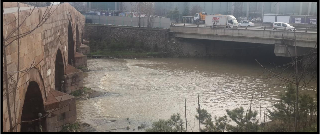
Şekil 4.16 8 numaralı noktadan mansap yönünde görünüş, Akköprü
