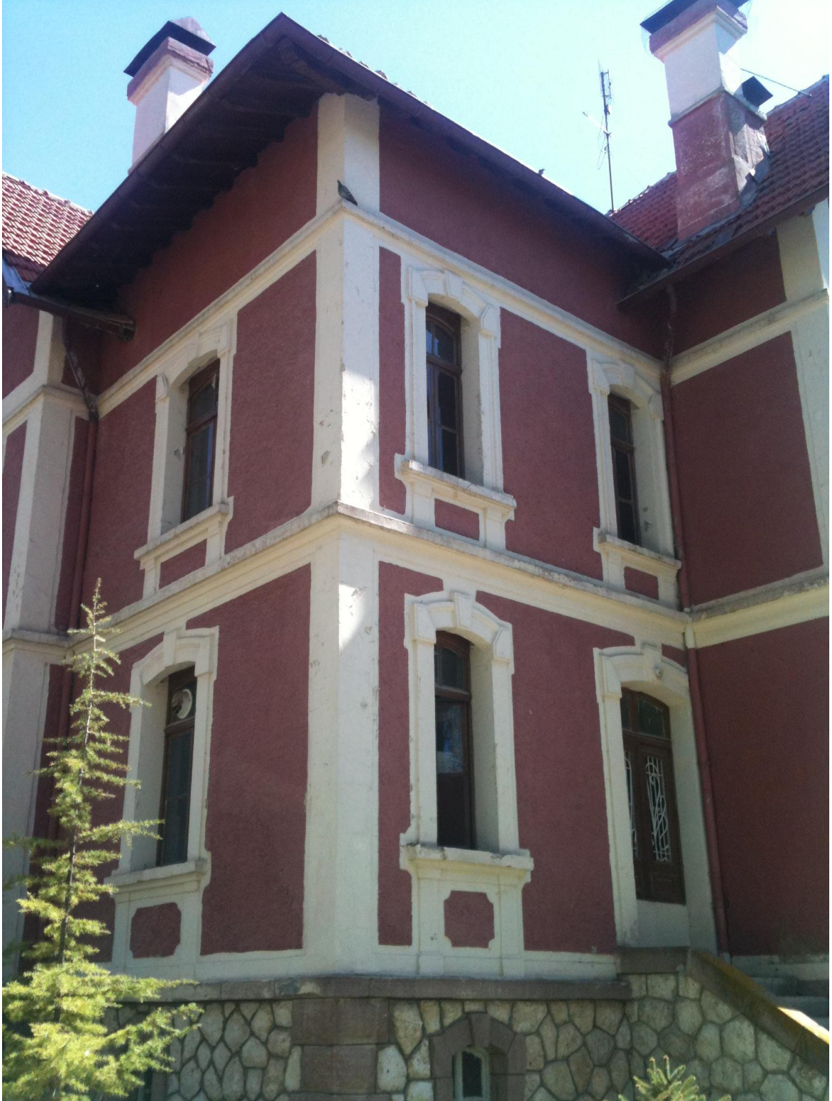
Devlet Su İşleri Çumra Bölge Müdürlüğü'nün bahçesinde bulunan, Sulama Projesi ve demiryolu inşaatı zamanında Almanların yaptığı yönetim binası.
