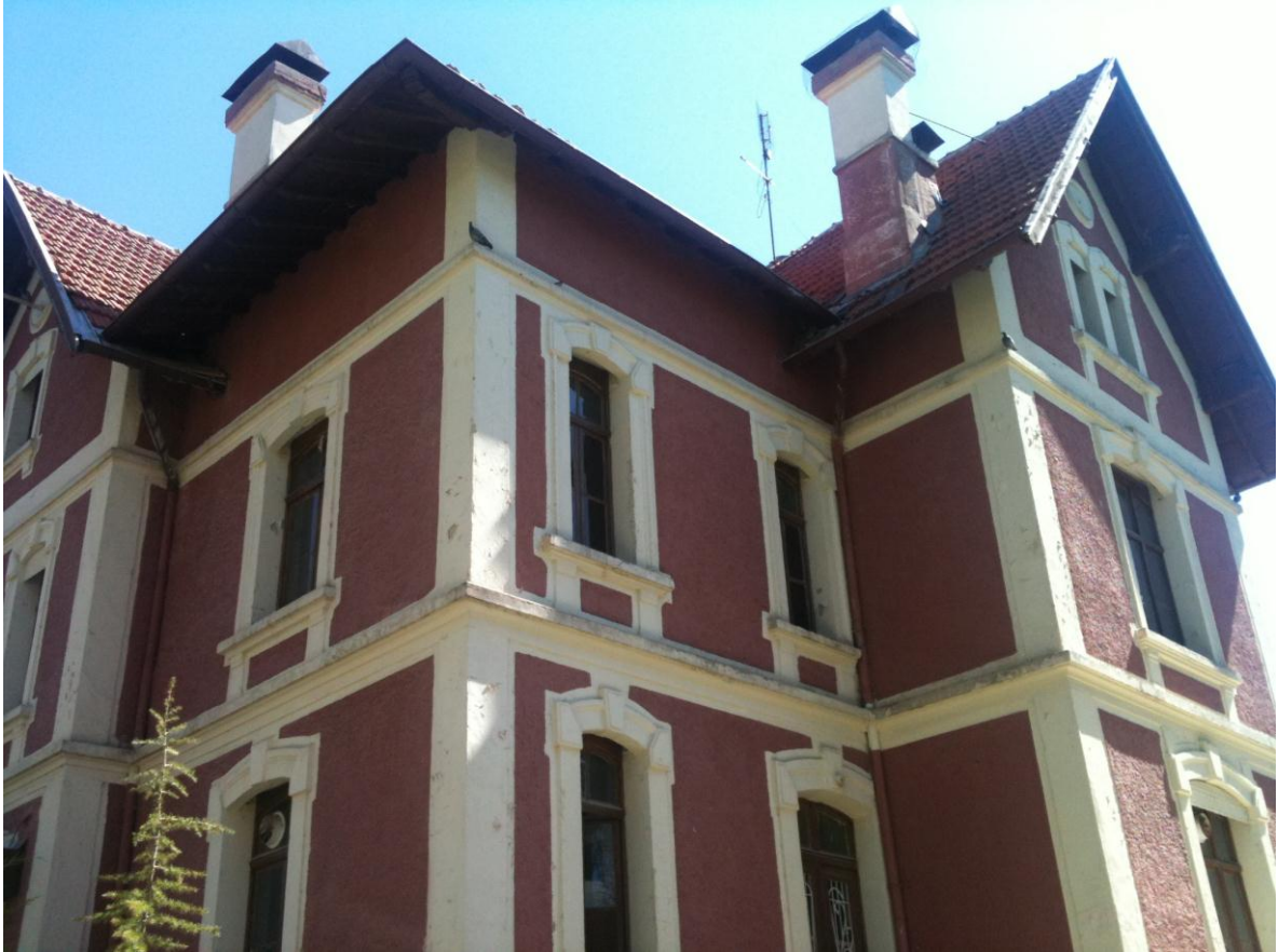
Devlet Su İşleri Çumra Bölge Müdürlüğü'nün bahçesinde bulunan, Sulama Projesi ve demiryolu inşaatı zamanında Almanların yaptığı yönetim binası. Binaya üstten bakıldığı zaman, çatı kısmının haç işareti şeklinde olduğu görülmektedir. (Foto: Fatih ÇOLAK-2011)
