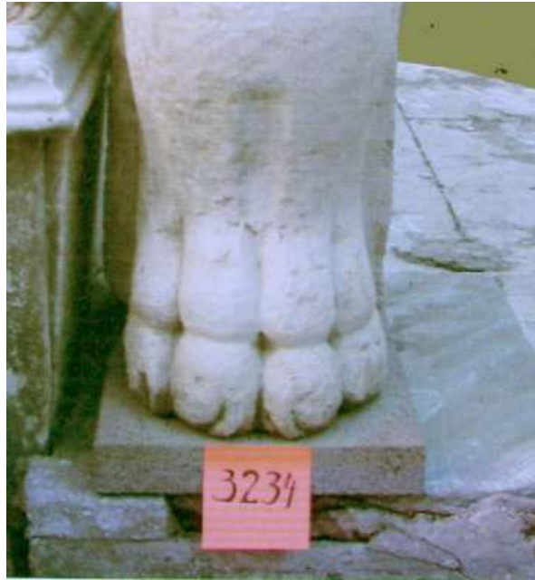
Resim 3: Konsol Ayađı yüzey korozyonu detay
