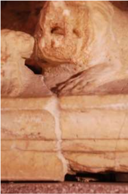
Resim 3: Ostotek Kapağı Parçası kırık ve çatlaklar detay
