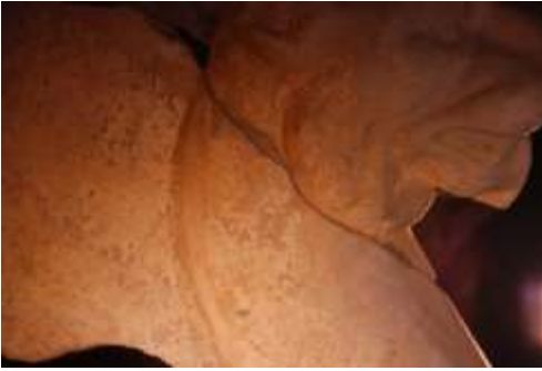
Resim 3: Aslanlı Konsol Ayağı kırık ve çatlaklar detay
