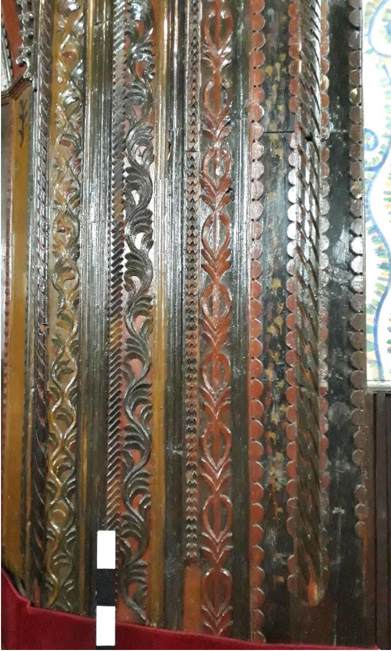
Fotoğraf 60: Dođanhisar Deřtiđin Cami Mihrap Çerçevesi
