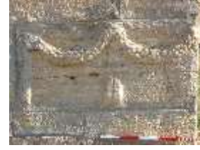
Ön cephe fotoğrafı
