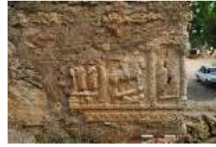
Ön cephe fotoğrafı
