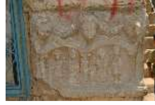
Ön cephe fotoğrafı
