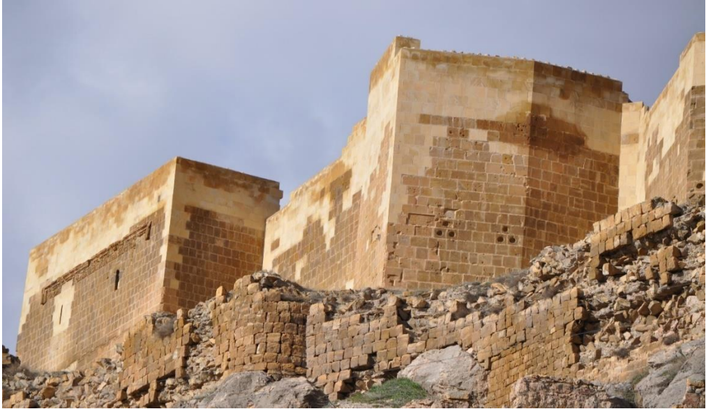
Resim 3: Kale Sur Duvarları
