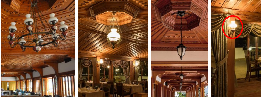
Şekil 4.48. Yücelen Otel restoran alanı aydınlatma elemanları
