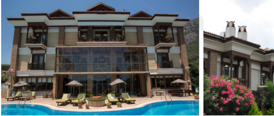
Şekil 4.55. Kerme Ottoman Palace Otel arka cephe ve baca detayları
