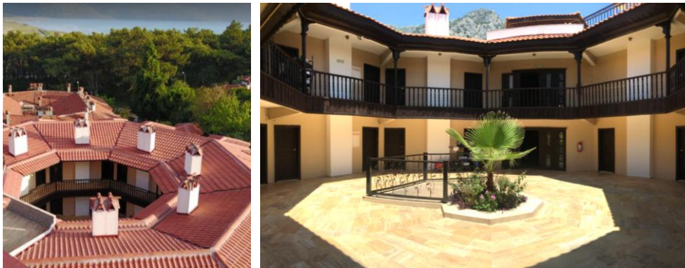
Şekil 4.14. Hanzara Otel A Blok görünüşleri
