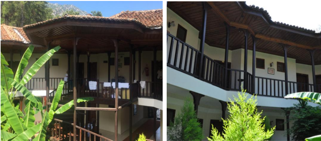
Şekil 4.38. Yücelen Otel/Çakırhan Konağı orta avlu ahşap detayları
