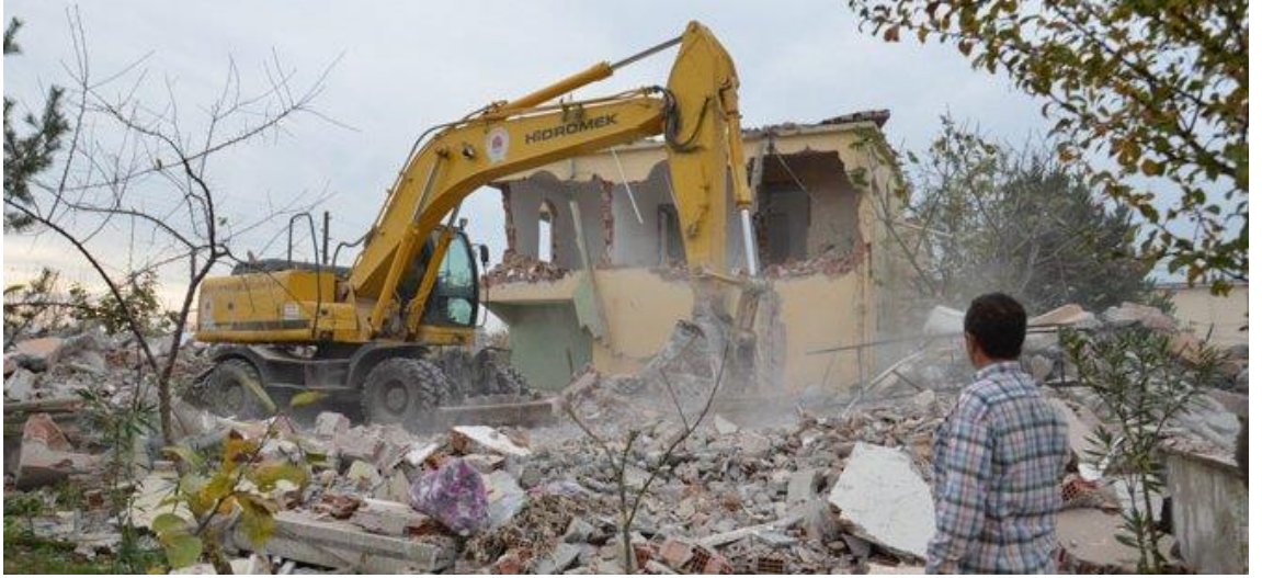
Fotoğraf 9: Kızılırmak Deltası Kuş Cenneti Sit Alanında Yapılan Kaçak Yapı Yıkımı
