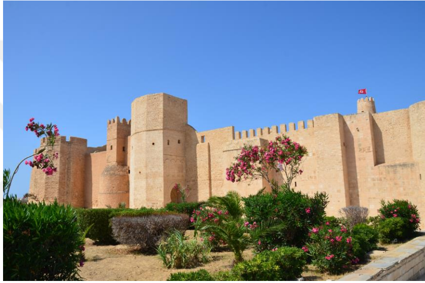
Resim 7: Sûse Ribâtı duvarları 768
