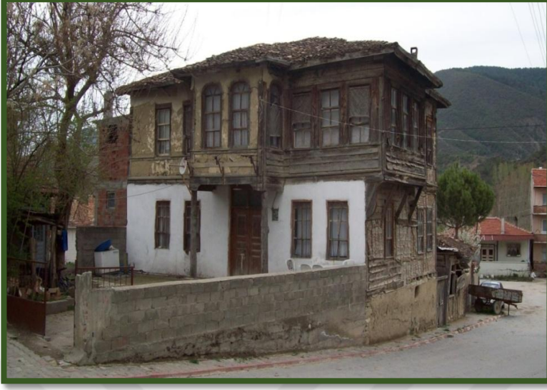
Şekil 6: Hanımeli Konağı'nın eski görünümü
